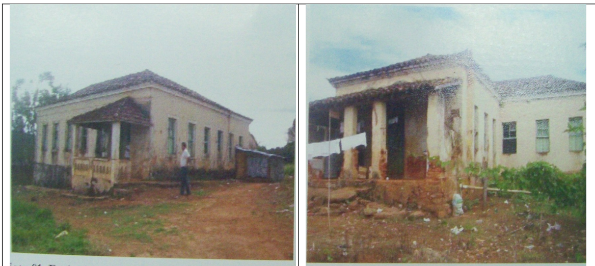
Figuras 03 e 04 – Vistas da edificação em mau estado de conservação, 2007. Fonte: Ficha de Inventário do Imóvel.
