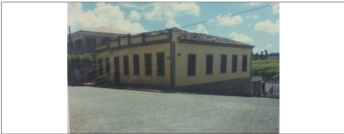
Figura 02 – Vista da edificação, 2007. Fonte: Dossiê de tombamento do imóvel.
