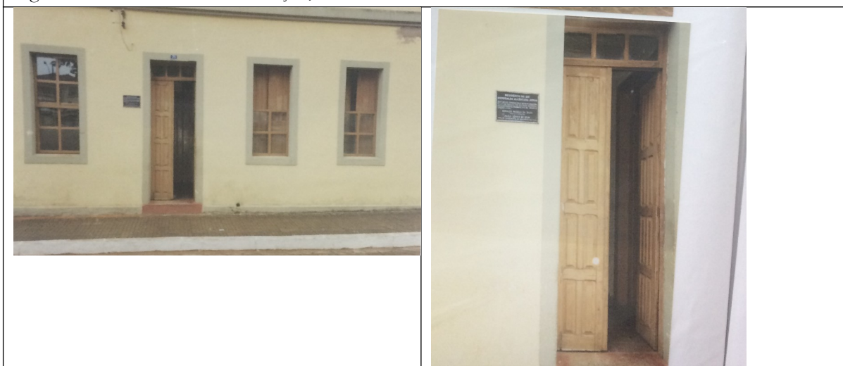
Figuras 12 e 13 – Vistas da edificação, 2004. Fonte: Dossiê de Tombamento do Imóvel
