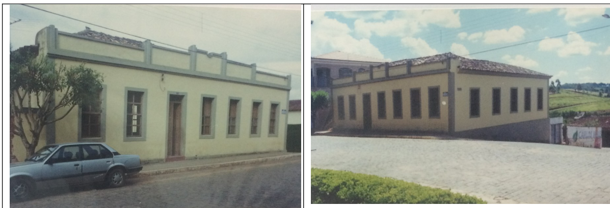
Figuras 10 e 11 - Vistas da edificação, 2004. Fonte: Dossiê de Tombamento do Imóvel
