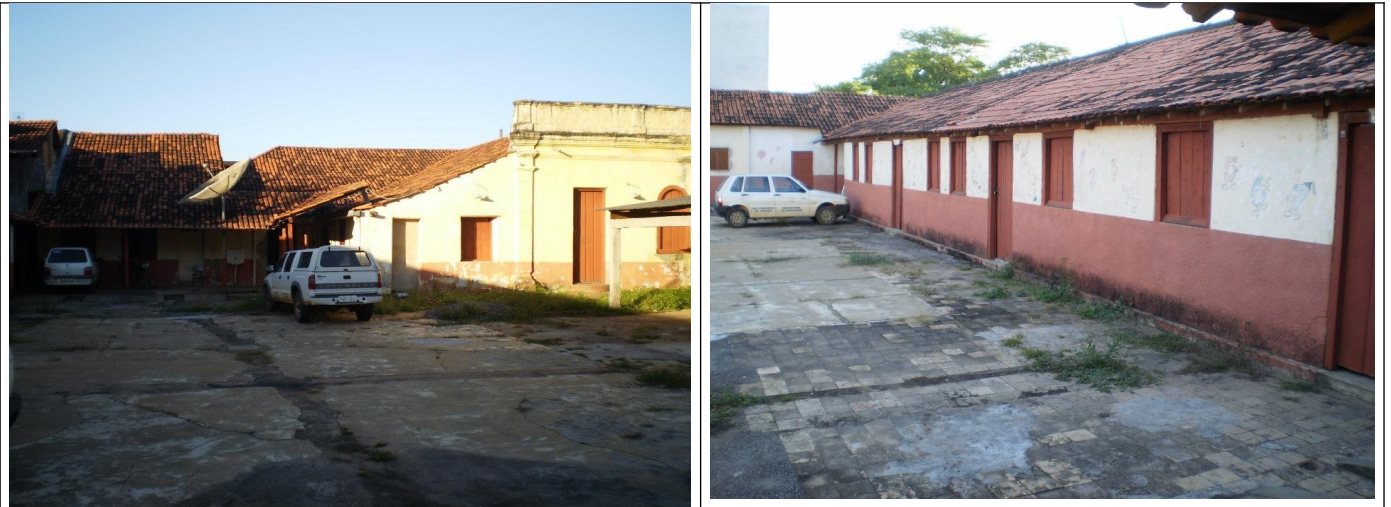
Figuras 05 e 06 – Acréscimos nos fundos da edificação.
