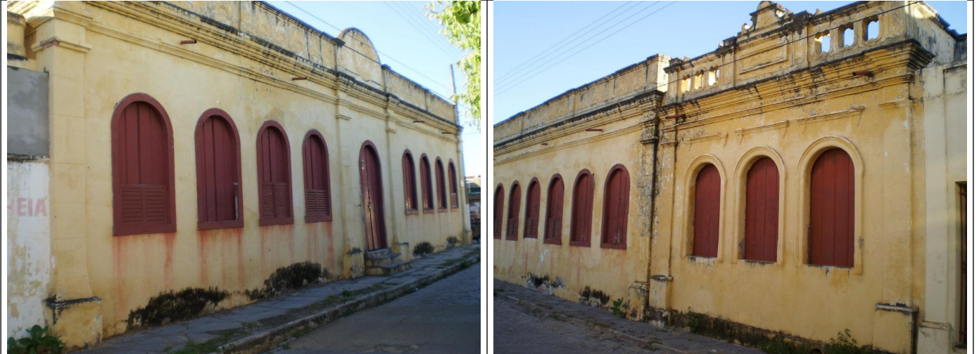
Figuras 03 e 04 – Fachadas da edificação.
