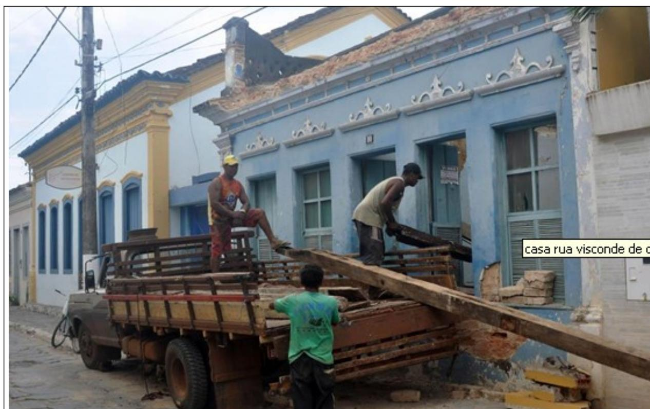
Figura 06 – Edificação em processo de demolição, com materiais sendo removidos para outro local.
