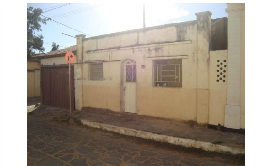
Figura 47 – Fachada principal. Foto: Marco Antonio Torres Euzébio
