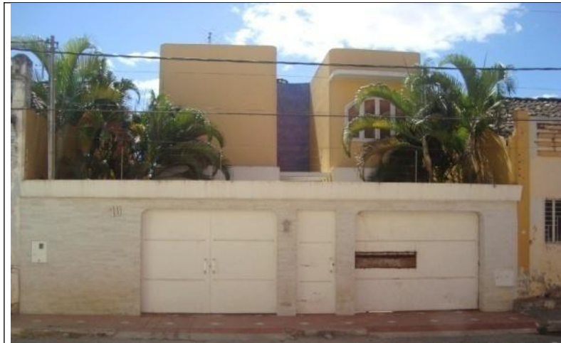
Figura 23 – Fachada principal. Foto: Marco Antonio Torres Euzébio
