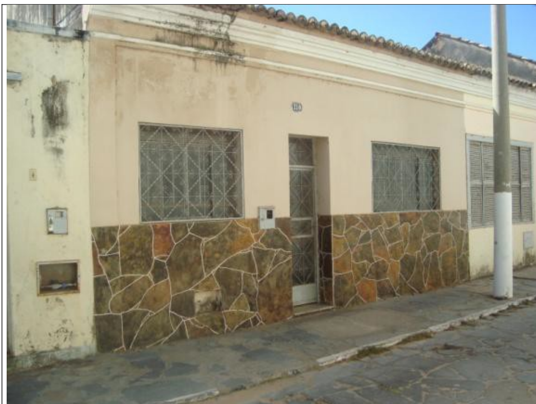
Figura 28 – Fachada principal. Foto: Marco Antonio Torres Euzébio
