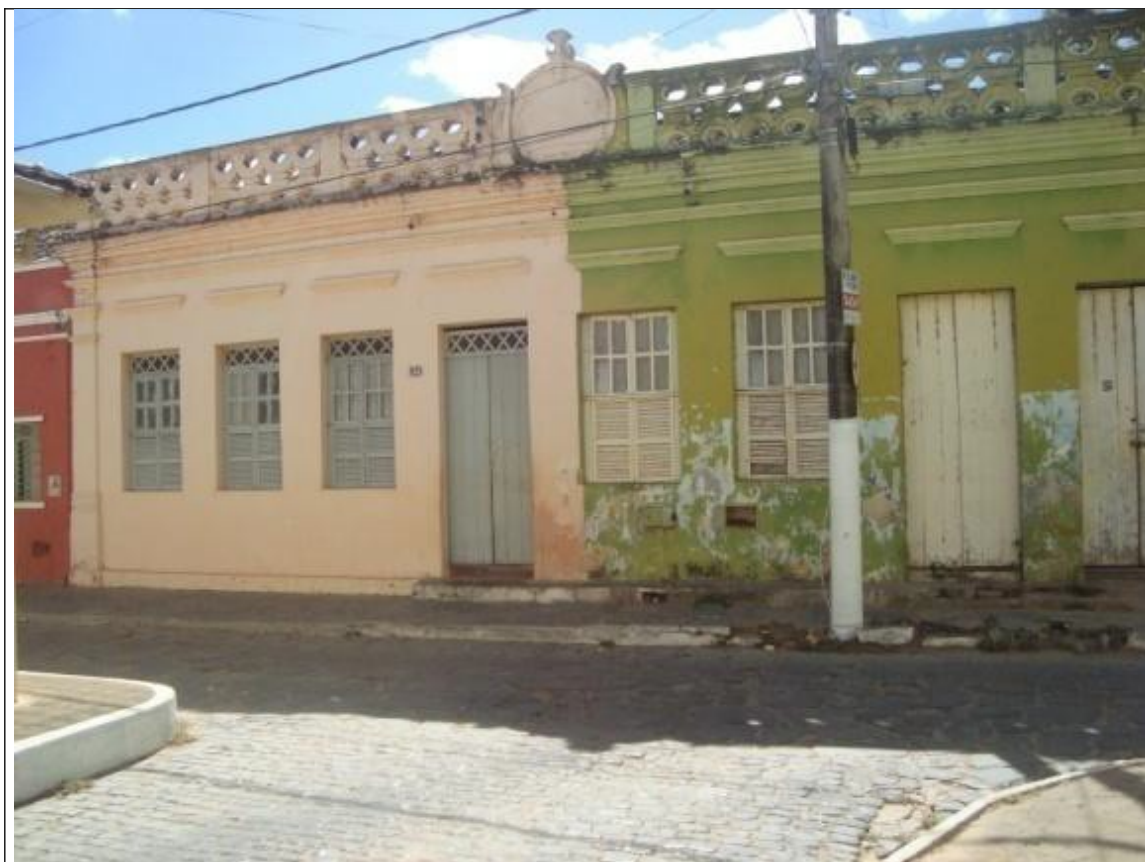
Figura 31 – Fachada principal. Foto: Marco Antonio Torres Euzébio
