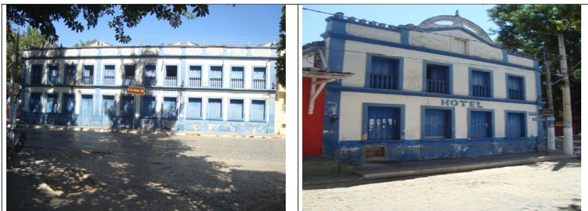
Figuras 19 e 20 – Fachadas do Minas Hotel. Fotos : Marco Antonio Torres Euzébio.
