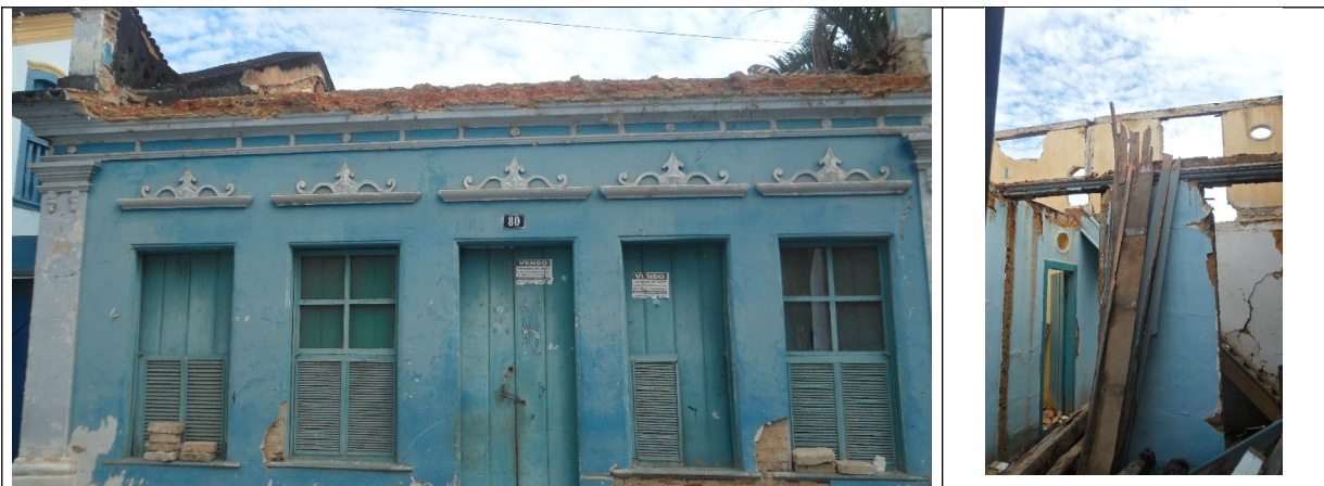
Figuras 24 e 25 – Fachada principal e imagem interna
