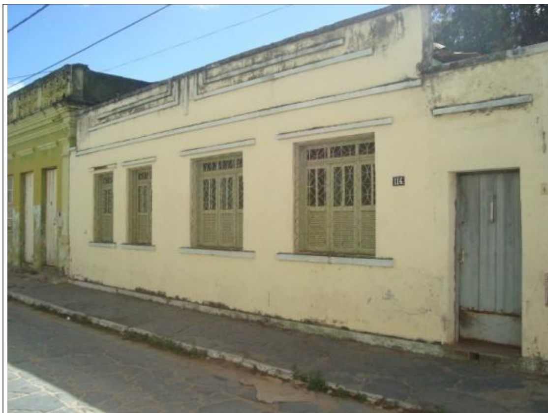
Figura 29 – Fachada principal. Foto: Marco Antonio Torres Euzébio
