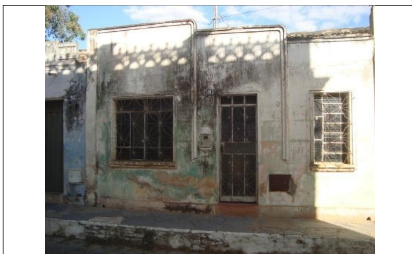
Figura 39 – Fachada principal. Foto: Marco Antonio Torres Euzébio
