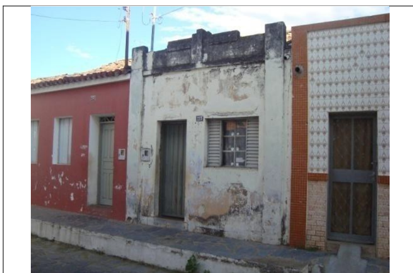
Figura 42 – Fachada principal. Foto: Marco Antonio Torres Euzébio
