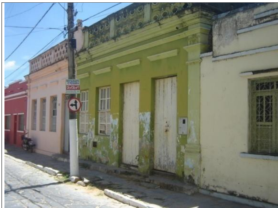
Figura 30 – Fachada principal. Foto: Marco Antonio Torres Euzébio
