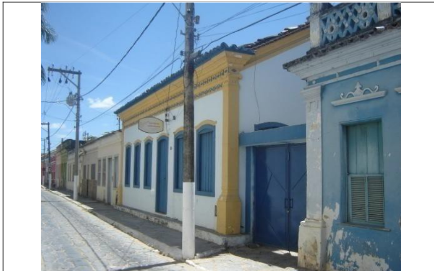
Figura 26 – Fachada principal. Foto: Marco Antonio Torres Euzébio
