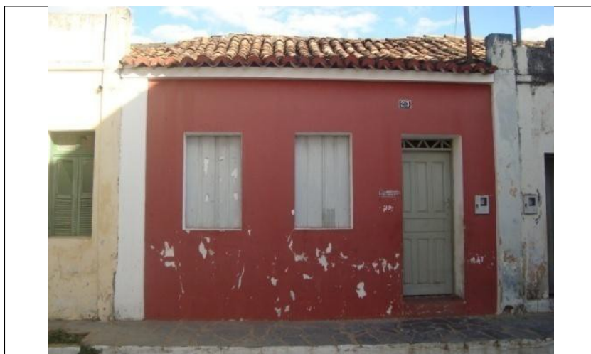
Figura 41 – Fachada principal. Foto: Marco Antonio Torres Euzébio
