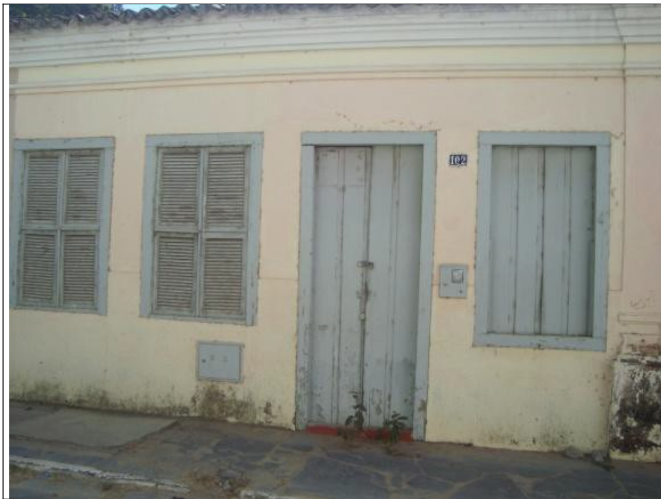
Figura 27 – Fachada principal. Foto: Marco Antonio Torres Euzébio
