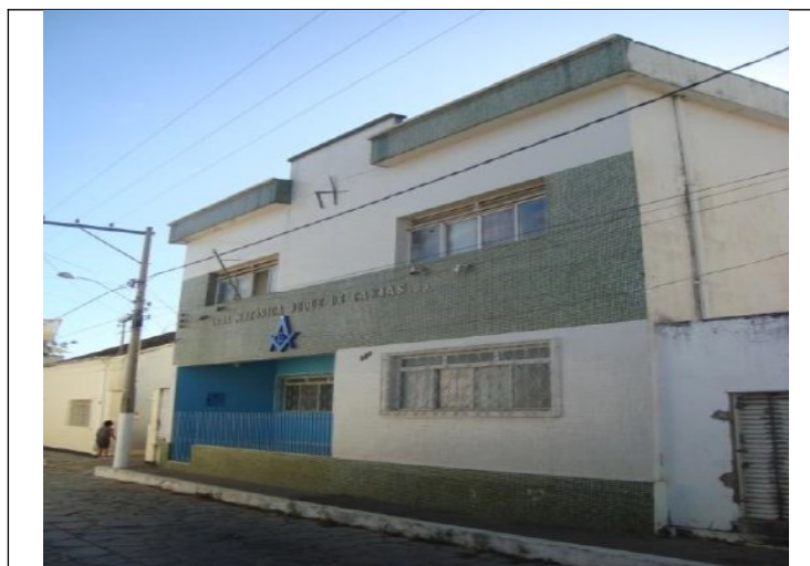
Figura 44 – Fachada principal. Foto: Marco Antonio Torres Euzébio
