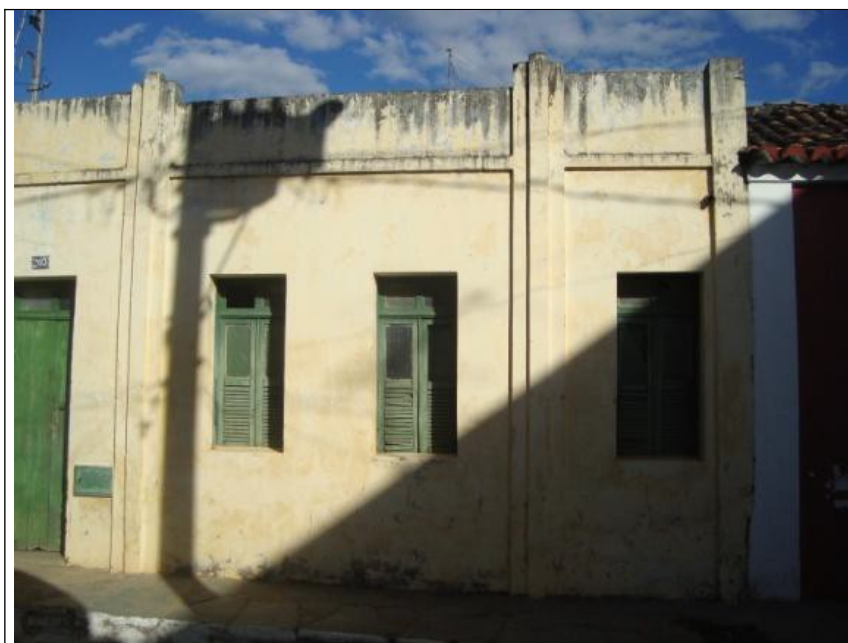
Figura 40 – Fachada principal. Foto: Marco Antonio Torres Euzébio
