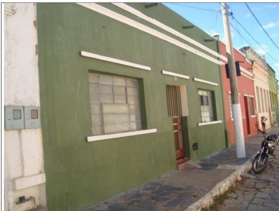
Figura 33 – Fachada principal. Foto: Marco Antonio Torres Euzébio
