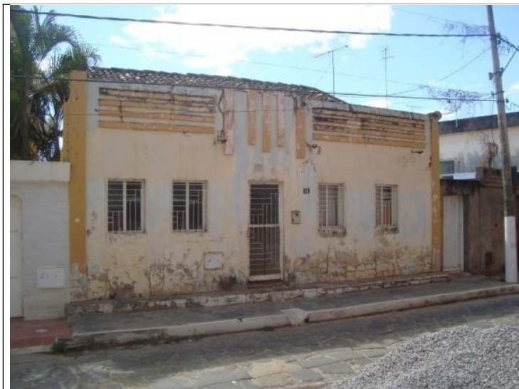
Figura 22 – Fachada principal. Foto: Marco Antonio Torres Euzébio
