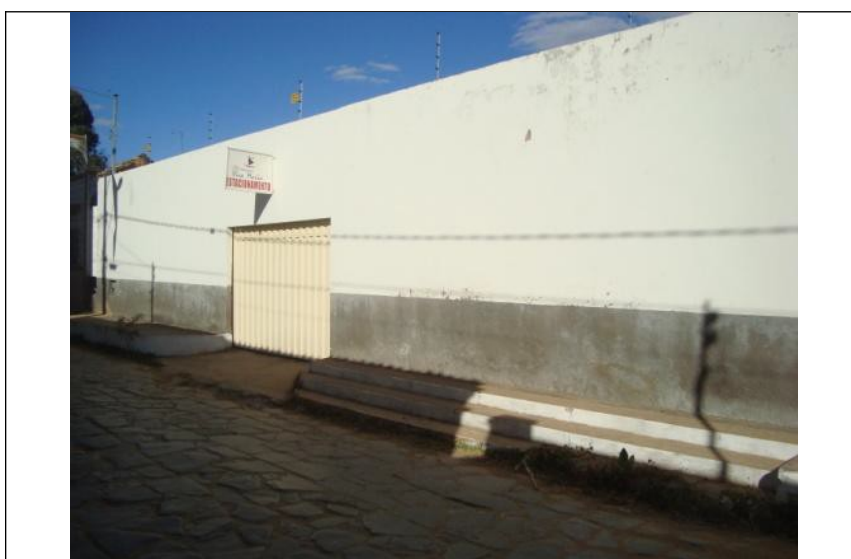
Figura 46 – Fachada principal. Foto: Marco Antonio Torres Euzébio
