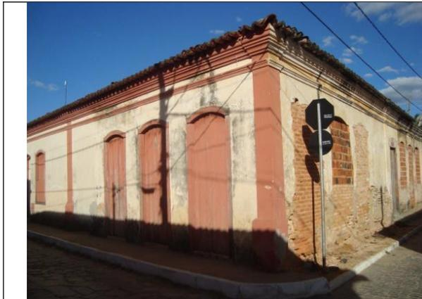
Figura 05 – Fachada principal, com presença de vedação dos vãos por alvenaria de tijolo. Foto: Marco Antonio Torres Euzébio, 2013.
