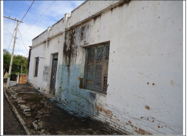
Figuras 01 e 02 – Fachada frontal e calçada adjacente em péssimo estado de conservação.
