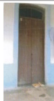
Figuras 9 e 10- Estação Ferroviária de Penido: portas de madeira deterioradas.
