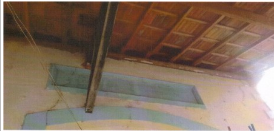
Figuras 5 e 6- Estação Ferroviária de Penido: alvenaria danificada no encontro com madeiramento.
