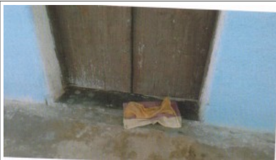
Figuras 9 e 10- Estação Ferroviária de Penido: portas de madeira deterioradas.
