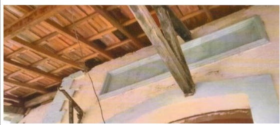
Figuras 5 e 6- Estação Ferroviária de Penido: alvenaria danificada no encontro com madeiramento.
