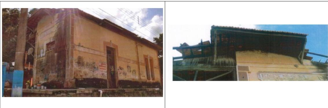
Figuras 5 e 6- Estação Ferroviária de Valadares: alvenarias degradadas e ausência de telhas na segunda imagem.
