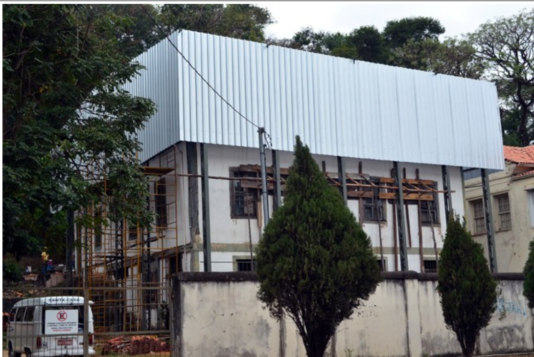
Figura 06 - Escoramento e cobertura provisória sobre parte da edificação.
