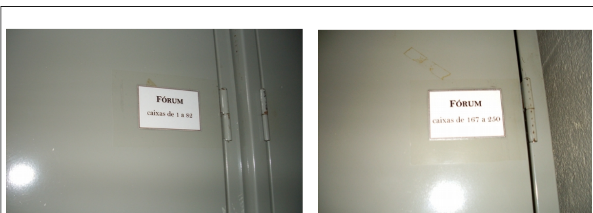
Figura 39 – Os armários estão identificados com etiquetas na porta.
