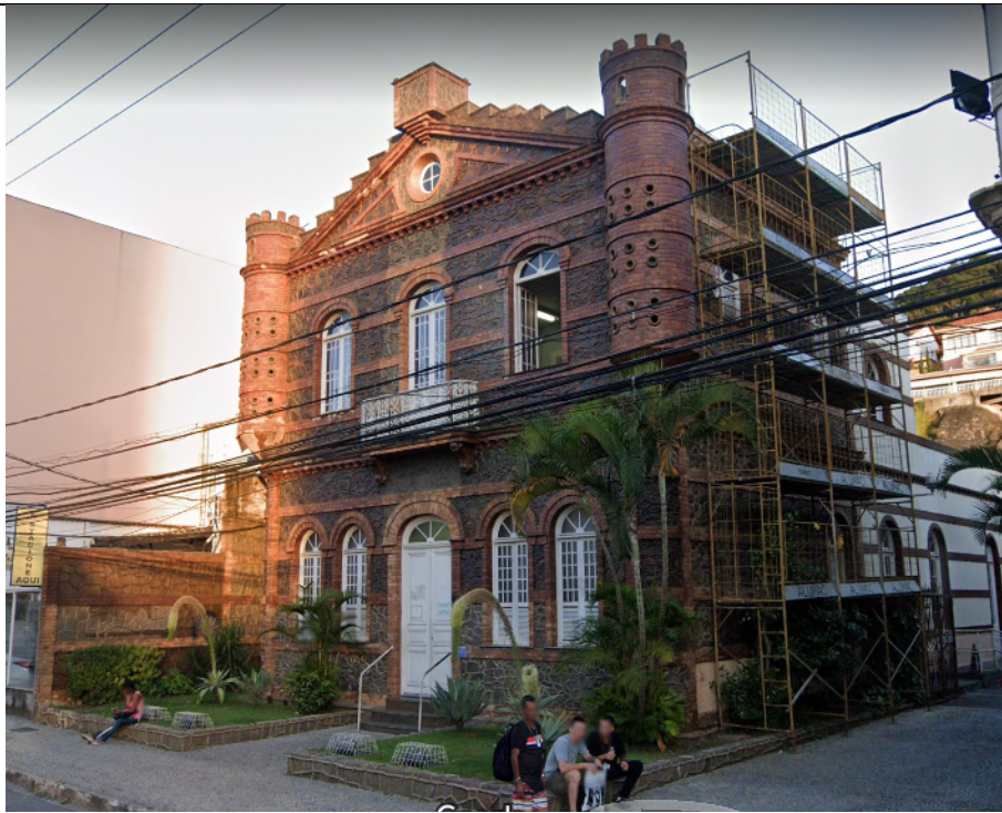
Figura 01 – Imagem do Google Street View de maio de 2019, com o andaime fachadeiro junto à fachada lateral.
