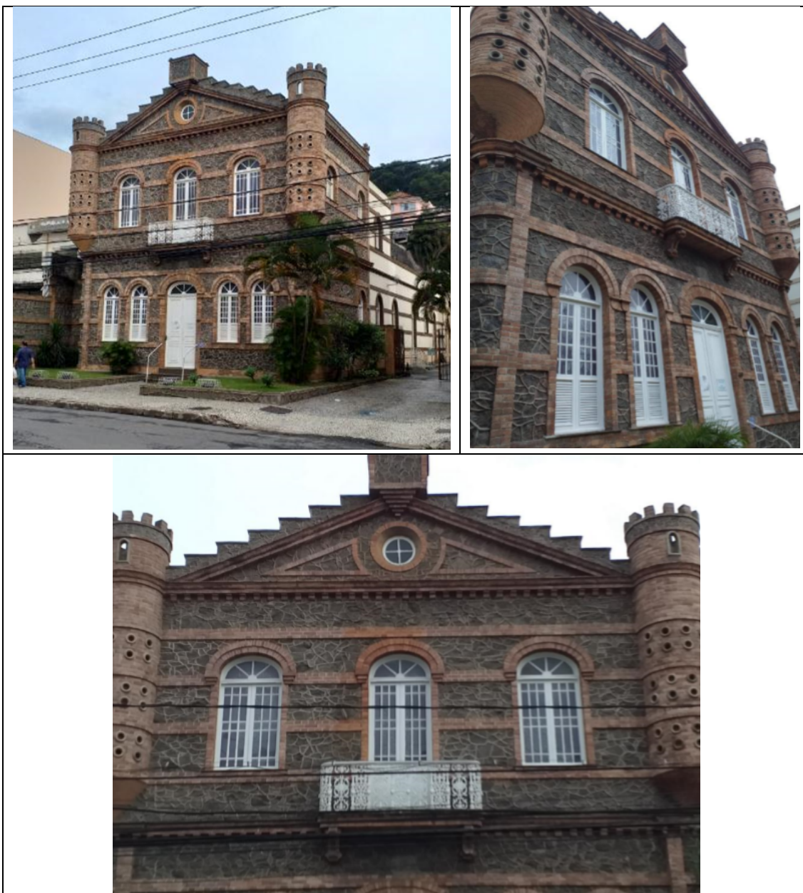
Figuras 02, 03 e 04 – Fachadas após as obras e intervenção. Fonte: ofício nº 44/2020 da Funalfa.
