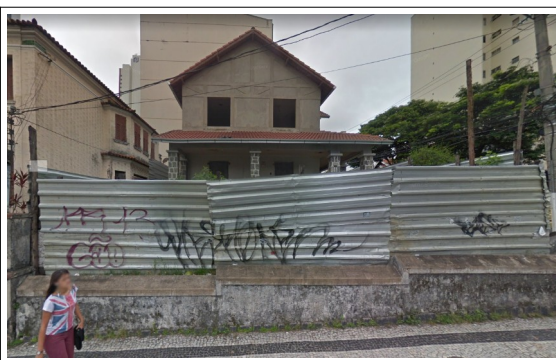
Figura 02 – Imóvel em abril de 2015, onde se observa a remoção dos ornamentos e janelas da fachada, e fechamento do gradil com placas metálicas. Fonte: Google Street View
