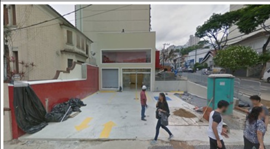
Figura 04 – Nova edificação do lote da antiga residência, já em fase de finalização de obras, em dezembro de 2017. Fonte: Google Street View.
