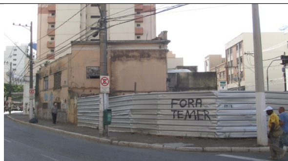
Figura 04 – Lateral esquerda e fundos da edificação em setembro de 2016.
