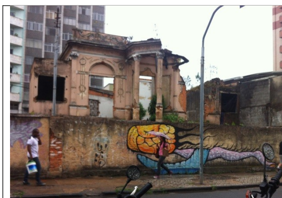
Figura 01 – Imagem da edificação em 21/03/2014.
