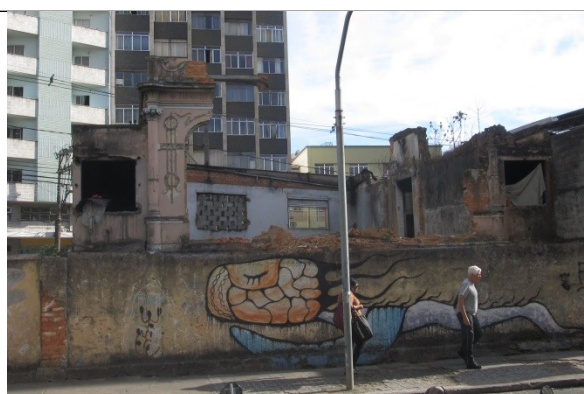
Figura 02 – Imagem da edificação em 06/09/2016.
