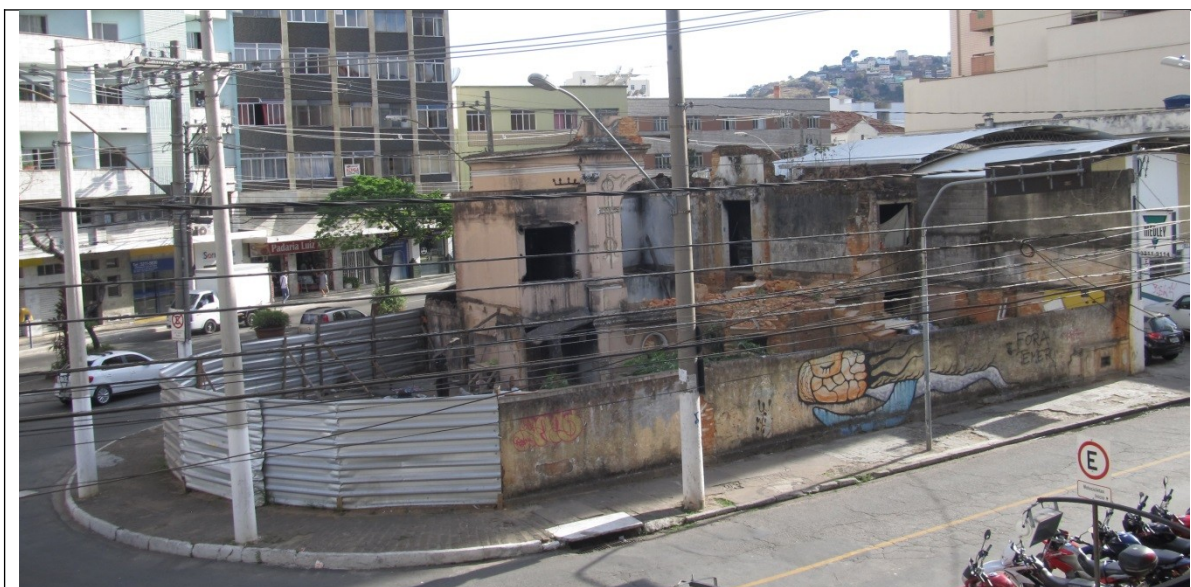
Figura 05 – Imagem geral do imóvel em setembro de 2016.
