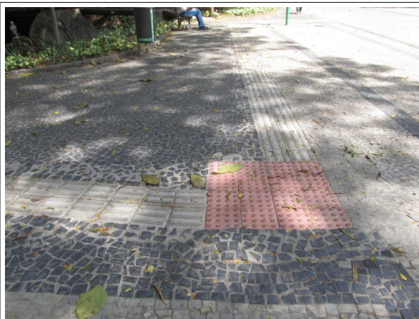
Figura 03 – Calçadas recuperadas com inserção de piso tátil.
