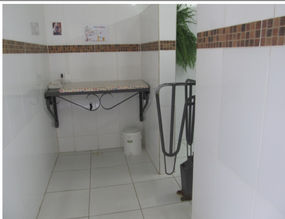
Figura 15 – Banheiro reformado e em utilização.
