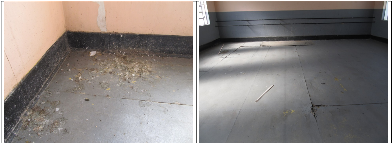
Figuras 20, 21, 22 e 23 - Fotos internas do segundo pavimento do prédio Long.
