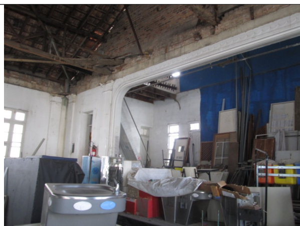
Figura 12 – Vista interna do ambiente anteriormente ocupado pelo Salão Nobre.
