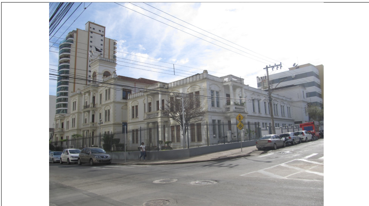
Figura 06 – Instituto Granbery, 2016. Foto da vistoria
