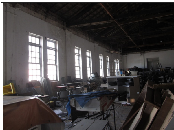
Figura 11 – Vista interna do ambiente anteriormente ocupado pelo Salão Nobre.
