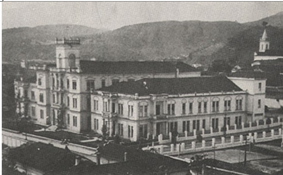
Figura 03 – Instituto Granbery Vista geral. Fonte: http://www.ricardoarcuri.com.br
