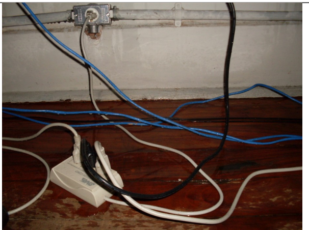
Figura 15– Fiação exposta, em contato com água. Foto contida no CD encaminhado pelo IBRAM em dezembro de 2011.
