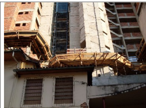
Figuras 16 e 17– Construção ao lado do imóvel, sem a tela de proteção. Fotos contidas no CD encaminhado pelo IBRAM em dezembro de 2011.
