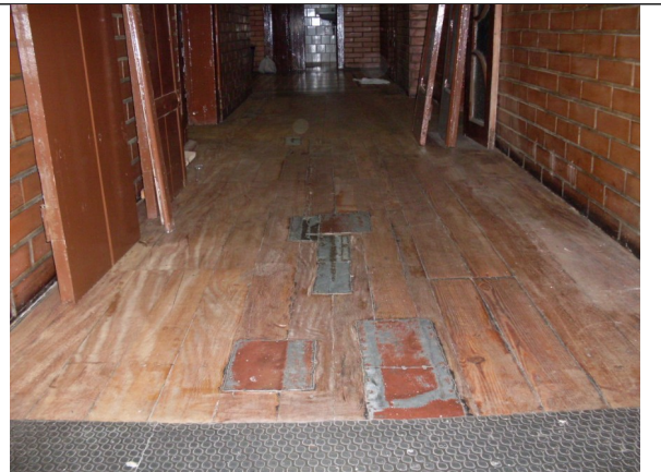
Figuras 12 e 13 – Patologias no piso de madeira. Fotos contidas no CD encaminhado pelo IBRAM em dezembro de 2011.
