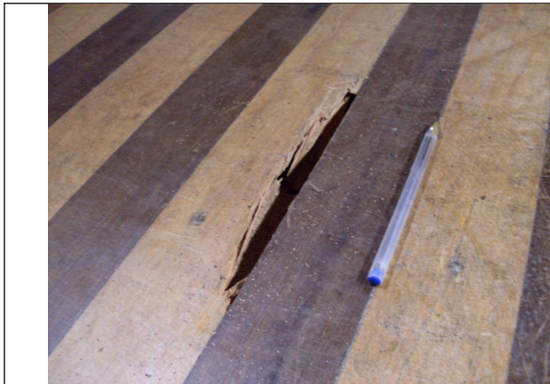
Figuras 12 e 13 – Patologias no piso de madeira. Fotos contidas no CD encaminhado pelo IBRAM em dezembro de 2011.
