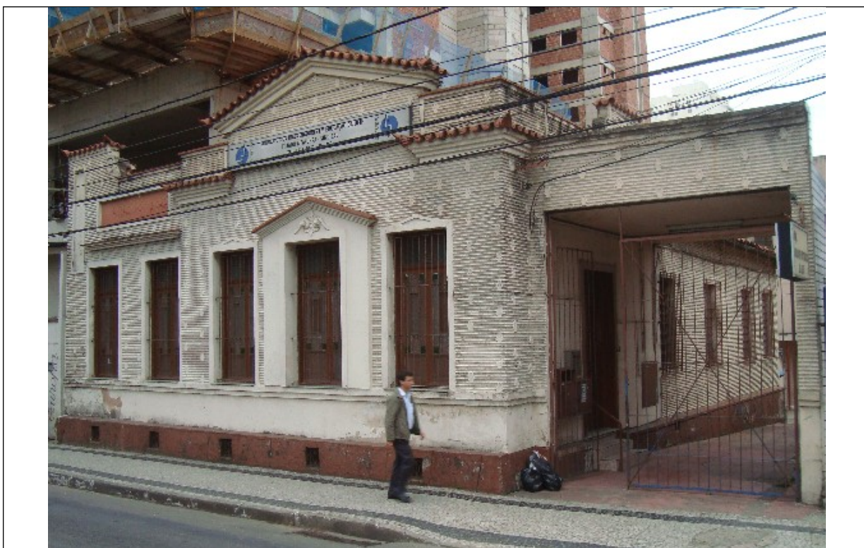
Figura 07- Imóvel situado à Avenida Rio Branco, nº 3460, em Juiz de Fora. Foto contida no CD encaminhado pelo IBRAM em dezembro de 2011.
