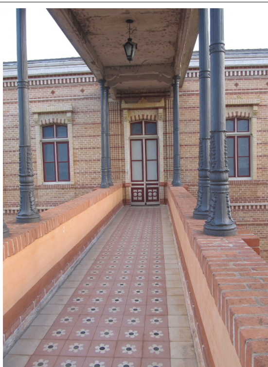
Figura 09 – Passarela que liga os dois prédios.
