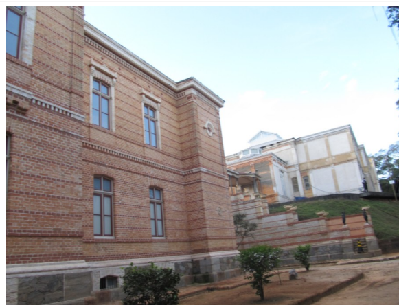
Figura 07 – Vista dos dois prédios.
