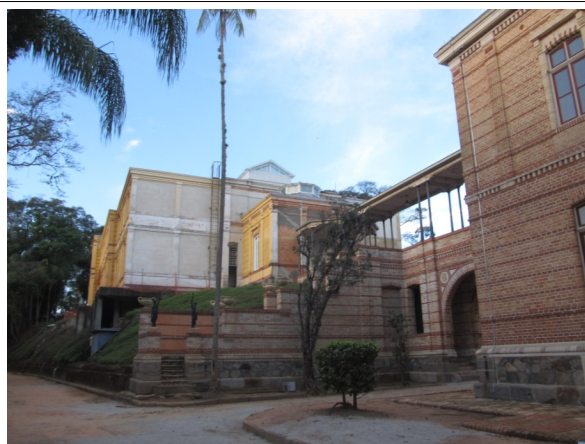
Figura 06 – Vista dos dois prédios.
