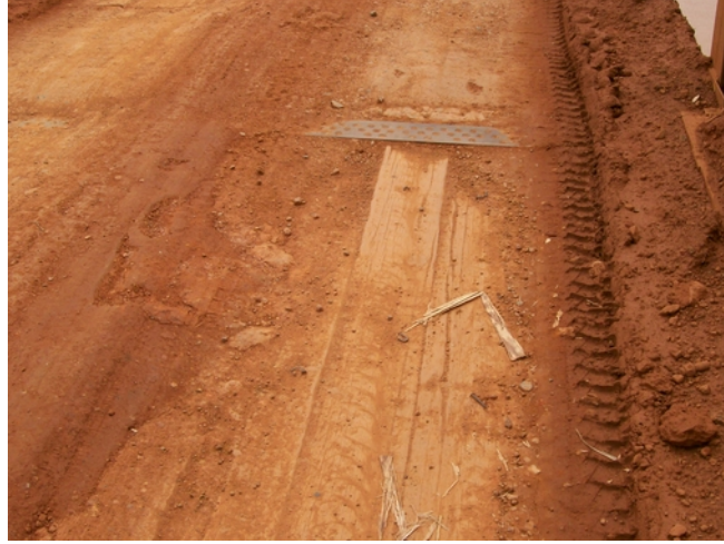
Figura 23 – Piso de concreto encoberto de barro e “emenda” com tábuas de madeira .
