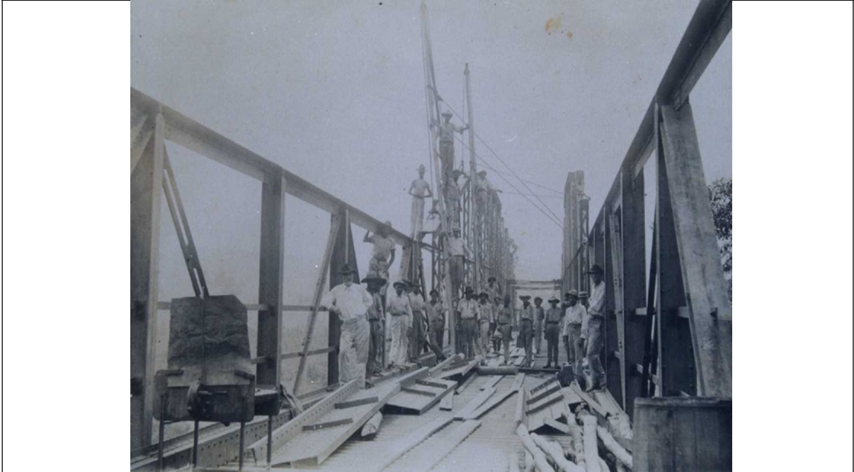
Figura 03 – Montagem / Construção da ponte
