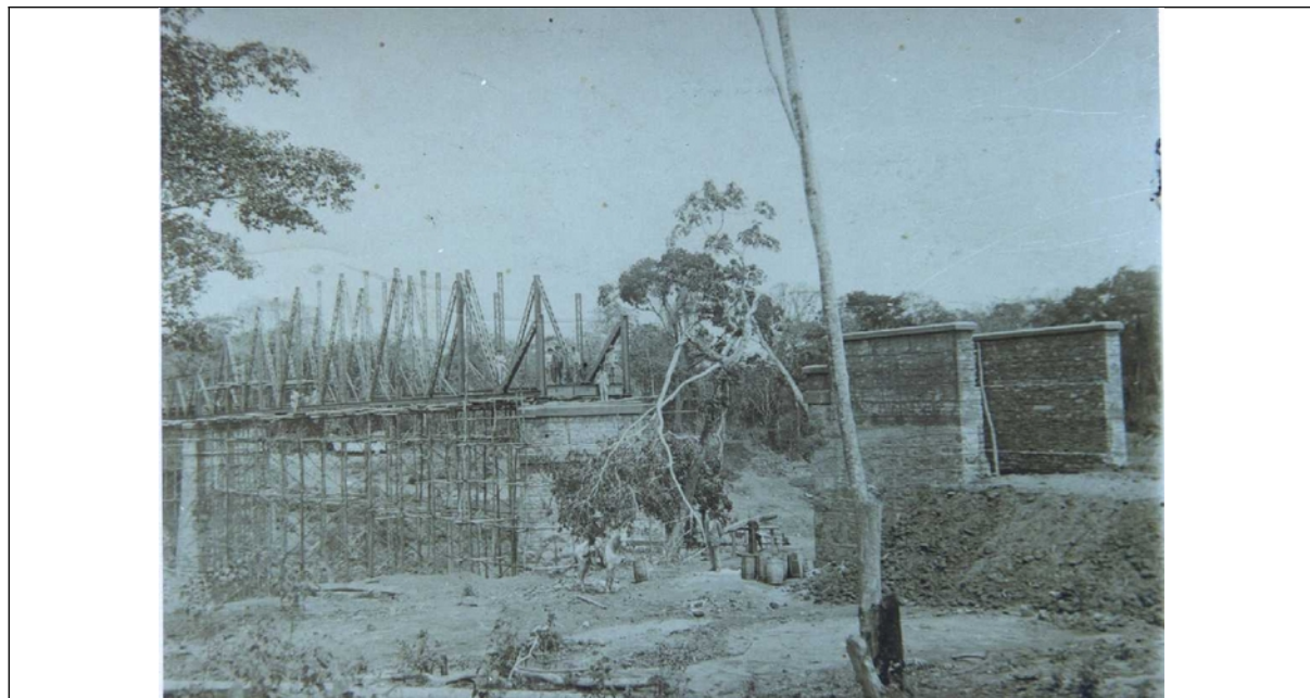
Figura 04 – Montagem / Construção da ponte
