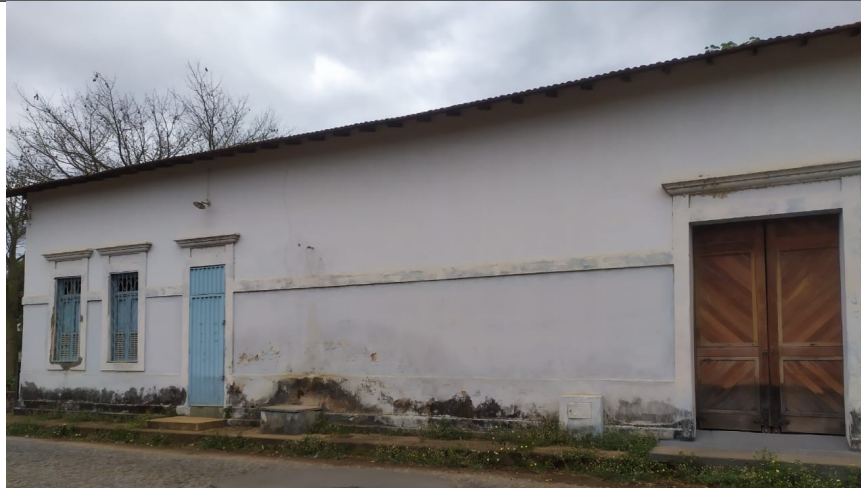
Figura 10 – Fachada de fundos.
