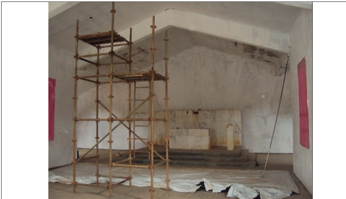
Figura 12 – Imagem interna da Capela Santa Clara evidenciam a realização de obras. BO N° M3698-2016-0330311, de 04/03/2016.
