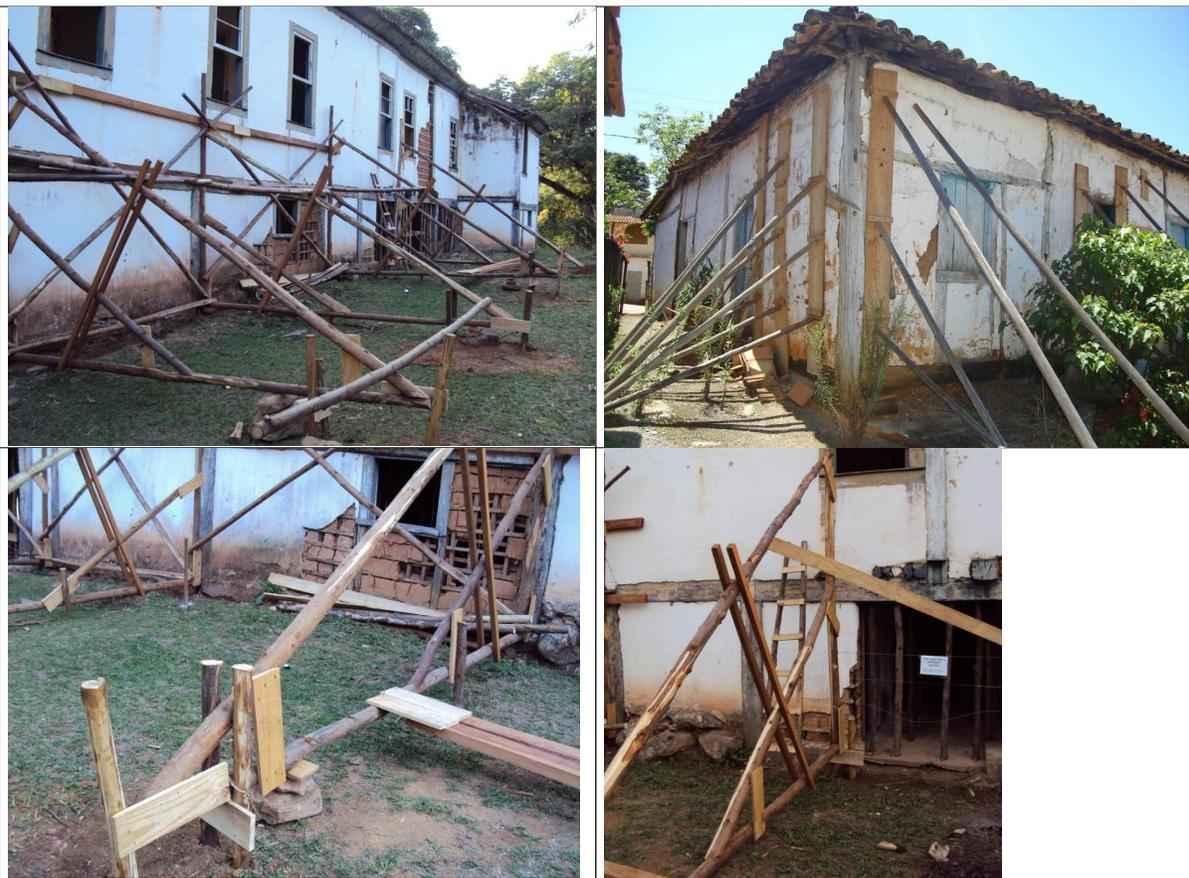
Figuras 04 a 07 – Escoramento de alvenarias.
