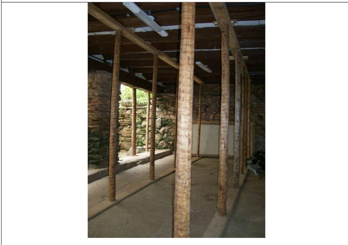
Figura 9 – Esquema para escoramento das peças de madeira do telhado, do piso (através do porão) e
