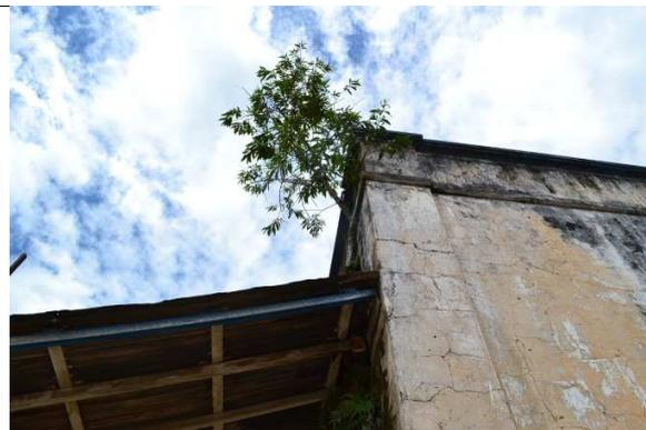
Figuras 09 e 10 – Crescimento de vegetação junto às alvenarias e na cobertura.
