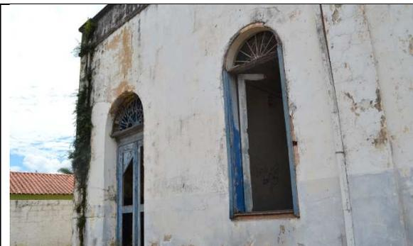
Figuras 11 e 12 – Crescimento de vegetação do terreno adjacente e junto aos elementos de drenagem.
