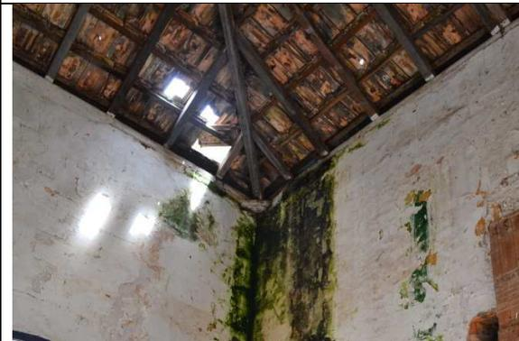
Figuras 15 e 16 – Comprometimento da cobertura, causando danos aos forros e alvenarias.
