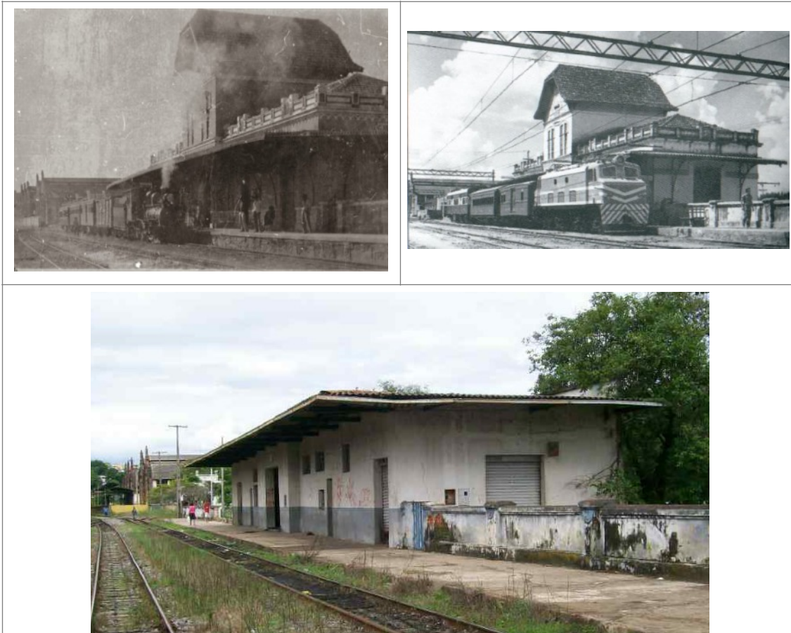
Figuras 6, 7 e 8 – Acima fotografias da Estação Ferroviária de Lavras retiradas em ângulo aproximado. Nota-se relevante diferença na estrutura do prédio. Na figura de número 6 e 7 o prédio da Estação aparece com o segundo andar que atualmente não existe, conforme se verifica na figura de número 8. A figura de número 6 apresenta a Estação provavelmente na década de 1980 – Acervo RFFSA. Detalhe das oficinas ao fundo. Fonte: Acervo da Promotoria Estadual de Defesa do Patrimônio Cultural e Turístico de Minas Gerais. Foto 6 disponível em: http://www.estacoesferroviarias.com.br/rmv_tronco/lavras.htm Acesso em: 16 de maio de 2011.
