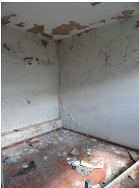
Figura 37 e 38 – Acima pormenores da parte interna de alguns cômodos do prédio em questão. Observa-se o descolamento de pintura, bem como a presença de entulho.
