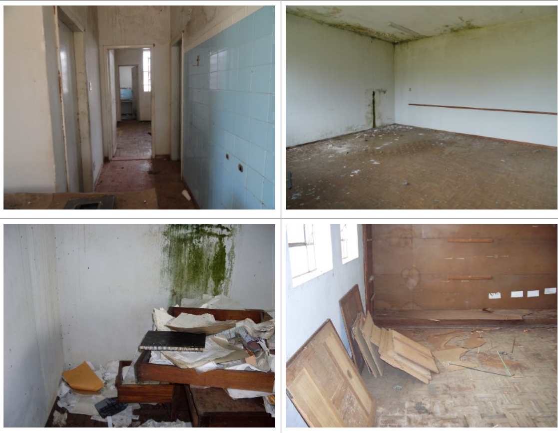
Figura 16 e 17 – Na página anterior pode-se ver à esquerda uma das laterais e a parte posterior do prédio, à direita pode-se verificar interior do prédio em questão. Verifica-se a presença de mofo nas paredes e muita sujeira no interior dos cômodos.
