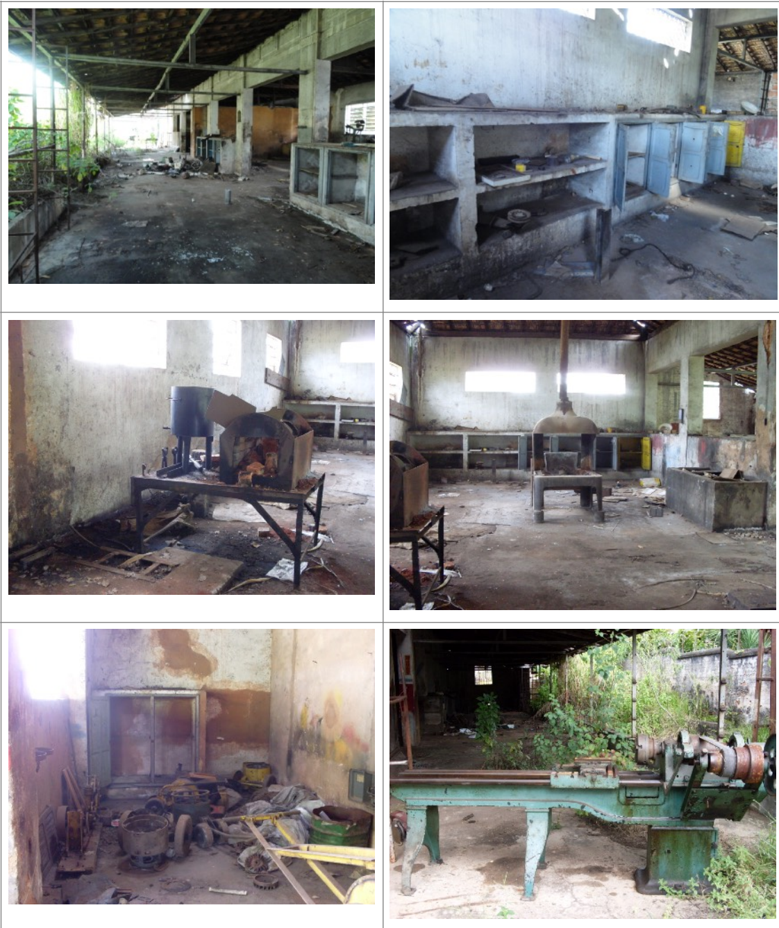
Figura 43 a 48 – Nas fotos acima é possível verificar maquinário abandonado no local. A vegetação está alta e peças diversas acumulam-se por toda parte.
