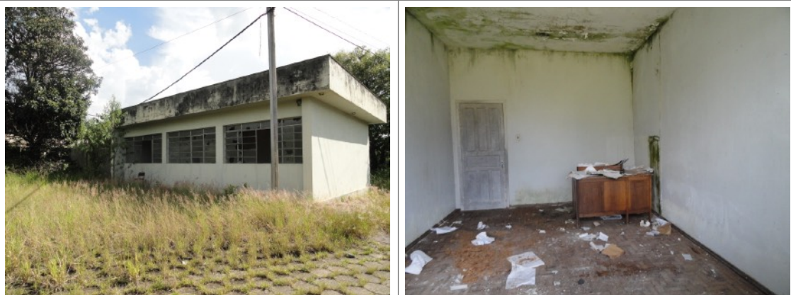
Figura 16 e 17 – Na página anterior pode-se ver à esquerda uma das laterais e a parte posterior do prédio, à direita pode-se verificar interior do prédio em questão. Verifica-se a presença de mofo nas paredes e muita sujeira no interior dos cômodos.
