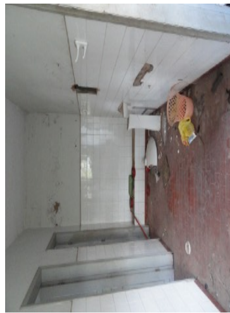
Figura 37 e 38 – Acima pormenores da parte interna de alguns cômodos do prédio em questão. Observa-se o descolamento de pintura, bem como a presença de entulho.
