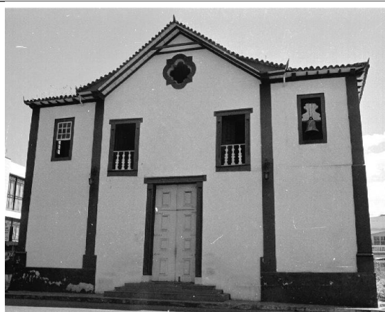
Figura 5 – Registro fotográfico do templo. S/d Fonte: Rede Social da internet. Acesso: 22 de outubro de 2013.
