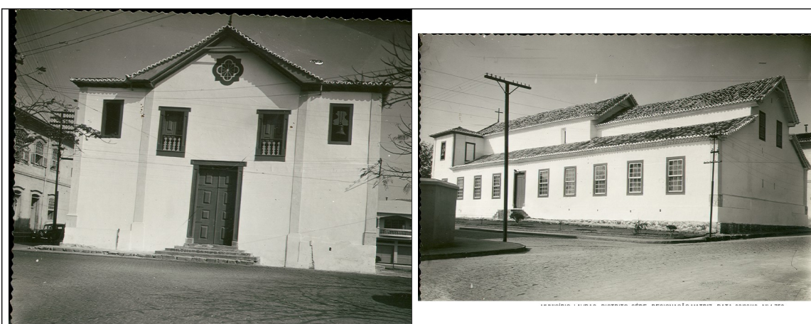
Figura 3 e 4 – Acima à esquerda fachada da Igreja do Rosário, acima à direita vista de uma de suas laterais. Ambas fotos datam de 30 de agosto de 1949, ou seja, foram tiradas aproximadamente um ano após o tombamento do templo.
