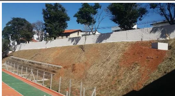
Figura 7 – Recuperação da quadra e do muro existente no entorno.
