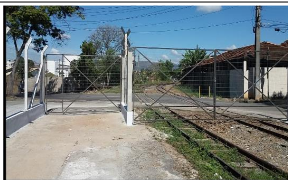
Figura 9 – Cercamento do entorno da estação.
