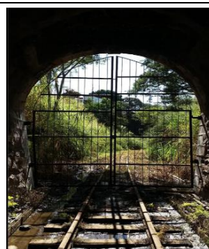
Figura 10 – Instalação de portão no túnel.
