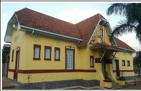
Figura 3 – Fachada de fundos.
