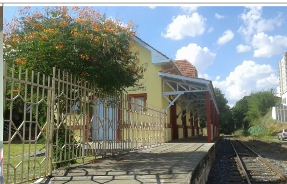
Figura 2 – Vista lateral com detalhe nos gradis
