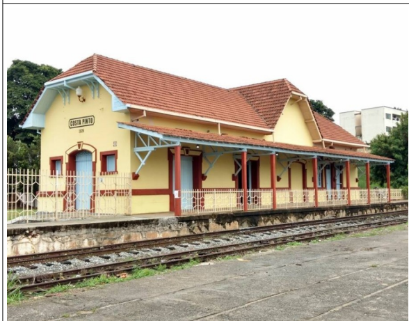
Figura 3 – Vista da parte posterior da edificação.
