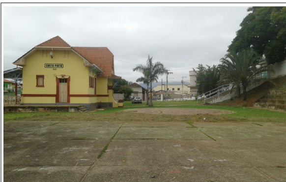
Figura 5 – Vista da estação com o pátio.
