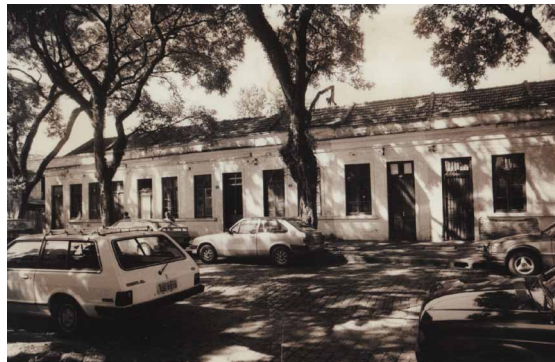
Conjunto de casas operárias, 4º Distrito, Porto Alegre.
