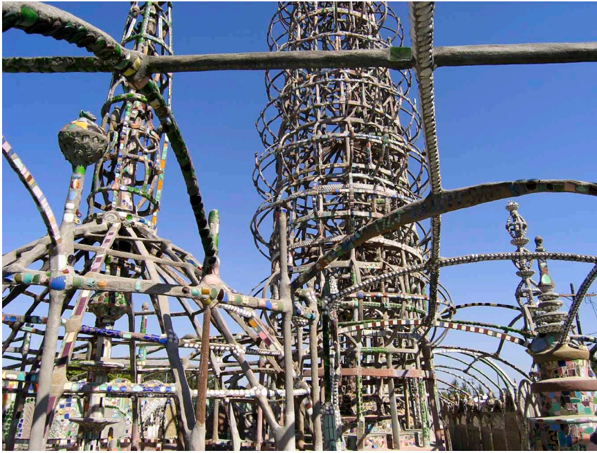
Watt Towers, Los Angeles.
