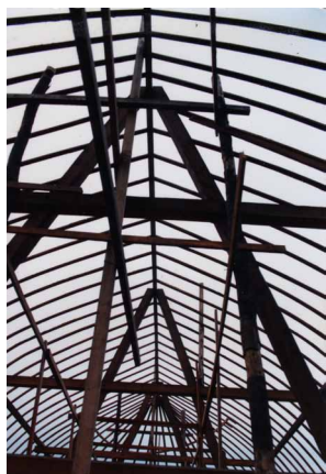
Estrutura da cobertura do Interior do Centro de treinamento, Cacoal, Rondônia.
