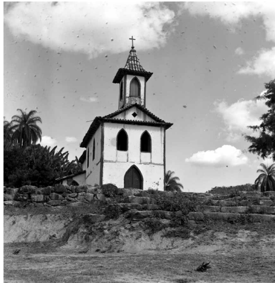
Capela, Distrito de Ravena, Sabará.
