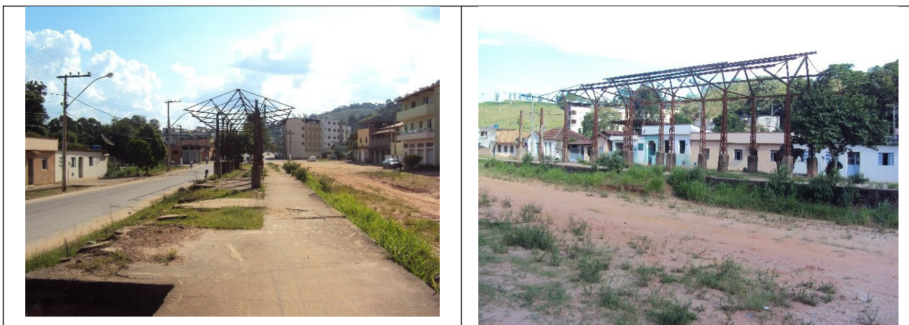
Figuras 09 e 10 – Vistas do que resta da estação ferroviária (estrutura metálica e plataforma).
