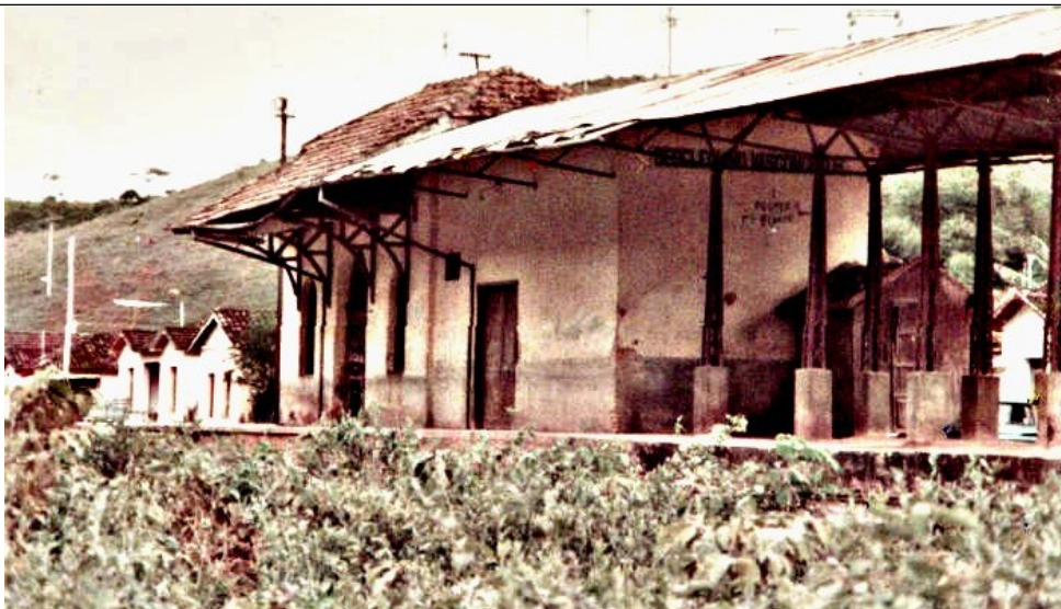
Figura 07 – Imagem antiga do imóvel, datada de 1972, contendo o imóvel da antiga estação e os acréscimos posteriores – armazém de carga e cobertura.
