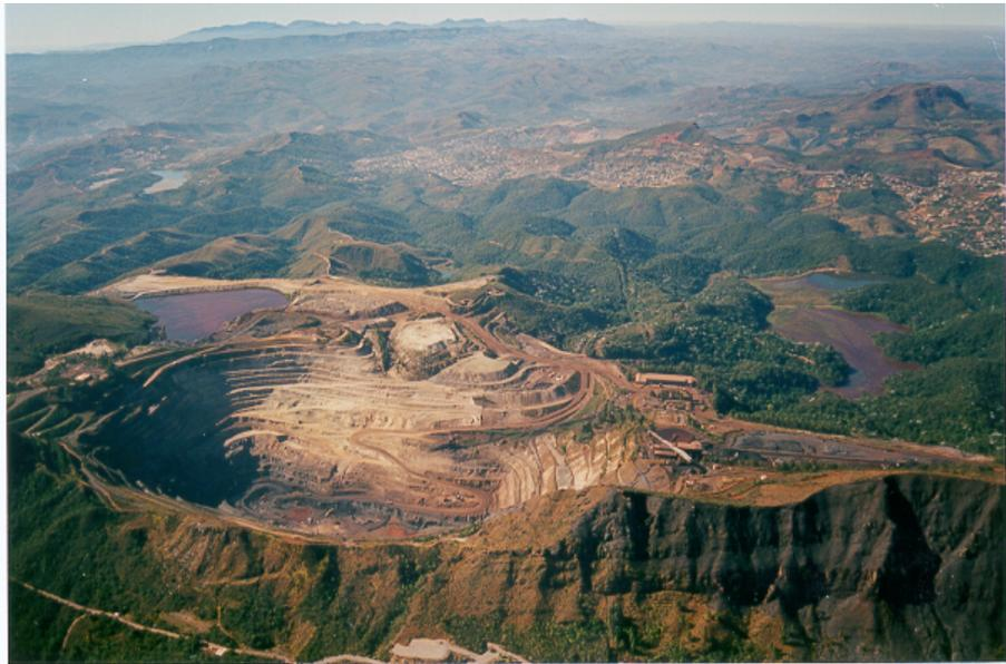
**FIGURA 3** | Vista geral da cava da Mina de Águas Claras, em 1998, incluindo a barragem de rejeitos (Barragem 5) à direita e dique de rejeitos (Grota 3 PFF) à esquerda. Fonte: MBR.
