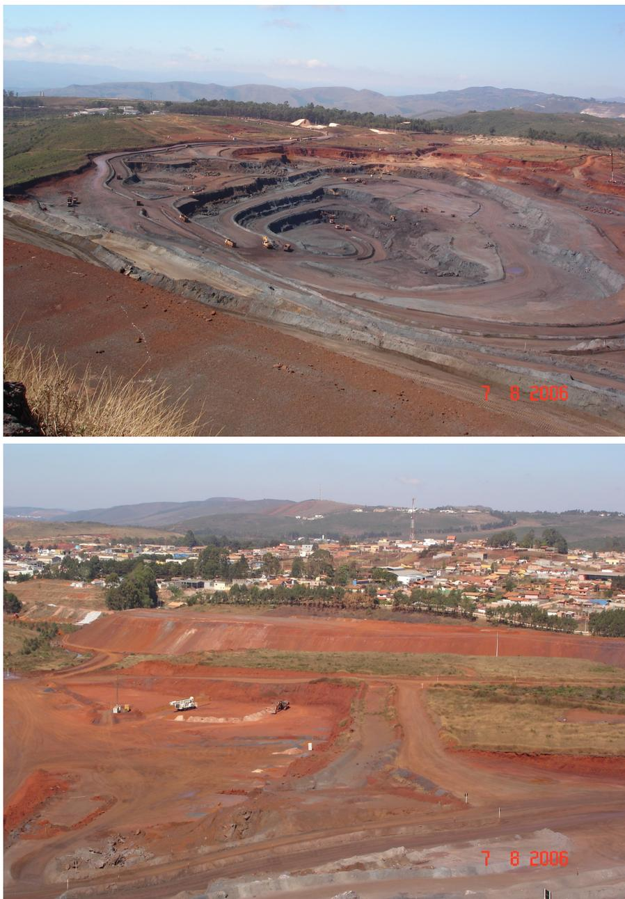
**FIGURA 12** | A imagem acima retrata a situação atual da cava da Mina de Capão Xavier (setor norte). A imagem baixo, pilha de estéril que funcionará como barreira visual e sonora para o Bairro Jardim Canadá, construída no limite da cava final projetada (setor sul)
