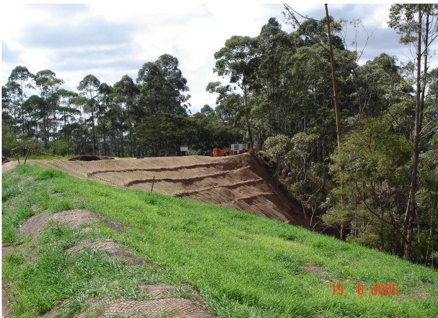
**FIGURA 9** | Na imagem acima, vista do talude da pera ferroviária; abaixo, detalhe do sistema de revegetação de taludes
