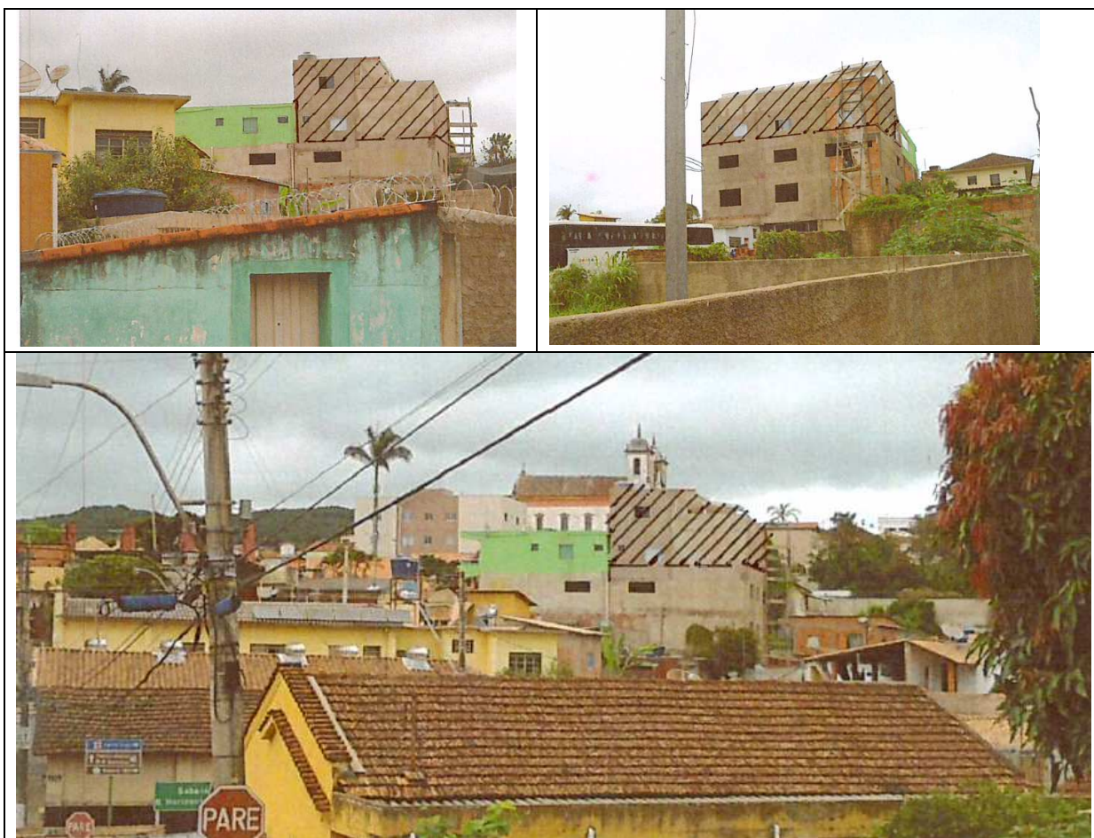
Figuras 14 a 16 – Imagens integrantes do laudo do Iphan que indicam com hachuras o trecho que recomendam a demolição.
