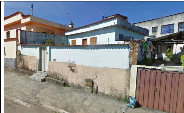
Figura 06 – Fachada do imóvel do ano de 2011, quando do tombamento do Núcleo do Centro Histórico. Fonte: Dossiê de Tombamento.
