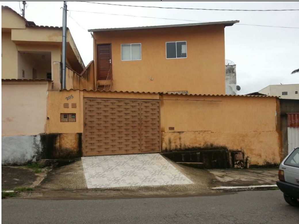
Figura 08 – Imagem atual da edificação.
