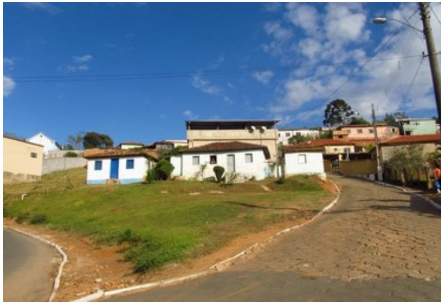
Figura 1- Imóveis de arquitetura vernacular, no estilo colonial, em Santa Rita do Ibitipoca. Foto da vistoria realizada em 24/07/2018.
