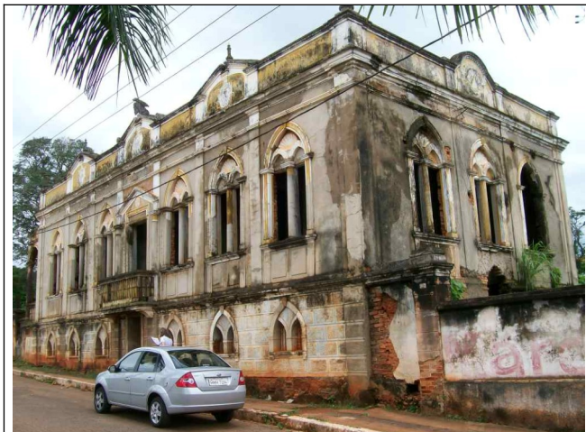
Figura 04 – Fachada frontal e lateral direita.
