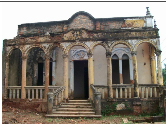
Figura 05 – Fachada lateral esquerda, onde se avista o alpendre lateral.
