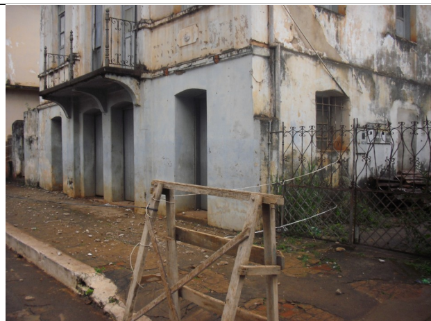
Figura 06 – Fachadas frontal e lateral direita.
