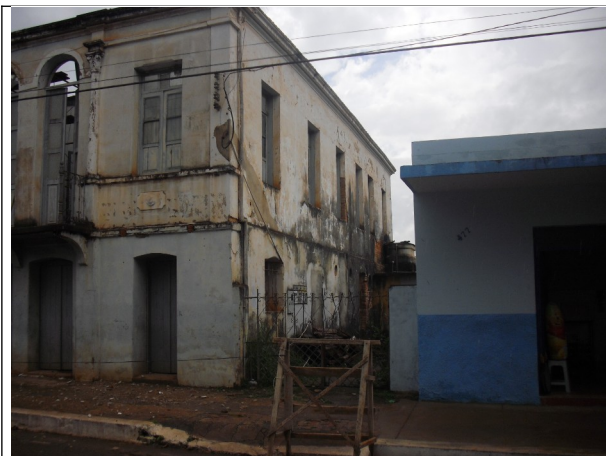
Figura 05 – Vista da fachada lateral direita.
