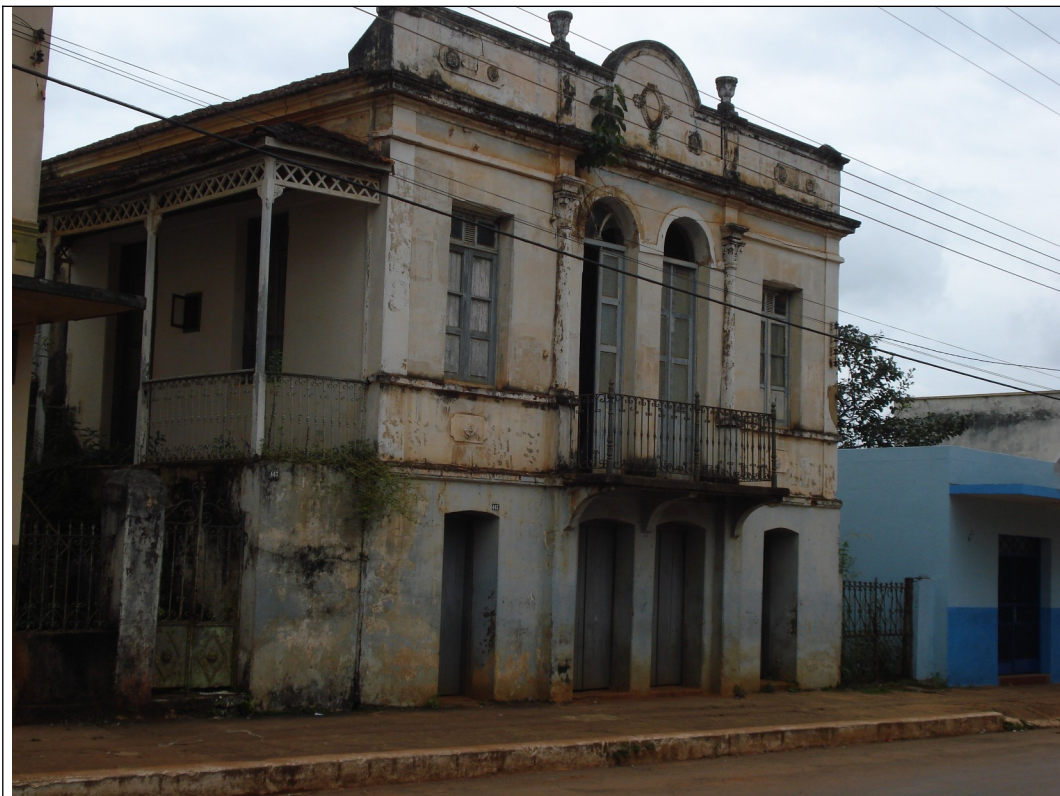
Figura 04 – Vista da frontal do imóvel antes do início da demolição.
