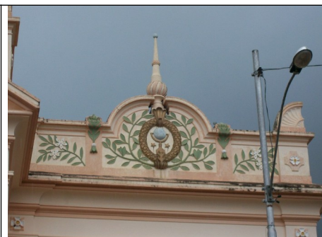
Figura 06 – Detalhe da platibanda
