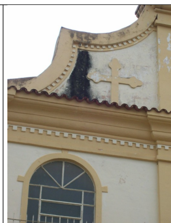
Figura 07 – Detalhe do coroamento.
