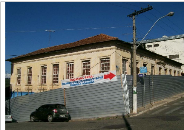
Figuras 06- Imagem do casarão cercado por tapumes feita no dia da vistoria.
