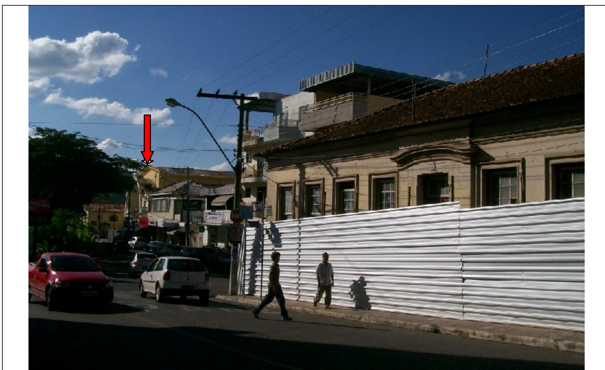
Figura 05- Imagem da fachada principal do casarão em análise, da Igreja Matriz (assinalada com a seta vermelha) e da Praça Antônio Carlos em Machado. Foto da vistoria em 18/04/2012.
