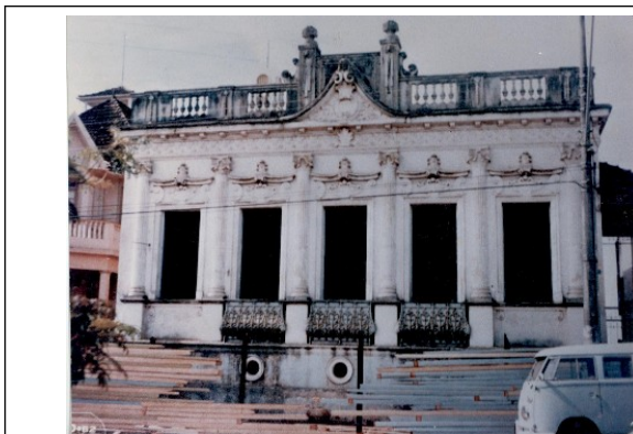
Figura 12- Fachada do casarão do Comendador Lindolfo Souza Dias. Edificação demolida em Machado. Fonte: Acervo fotográfico da Casa da Cultura de Machado.
