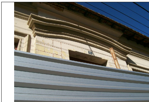
Figura 10- Imagem da porta de entrada do casarão cercado pelos tapumes. Foto da vistoria
