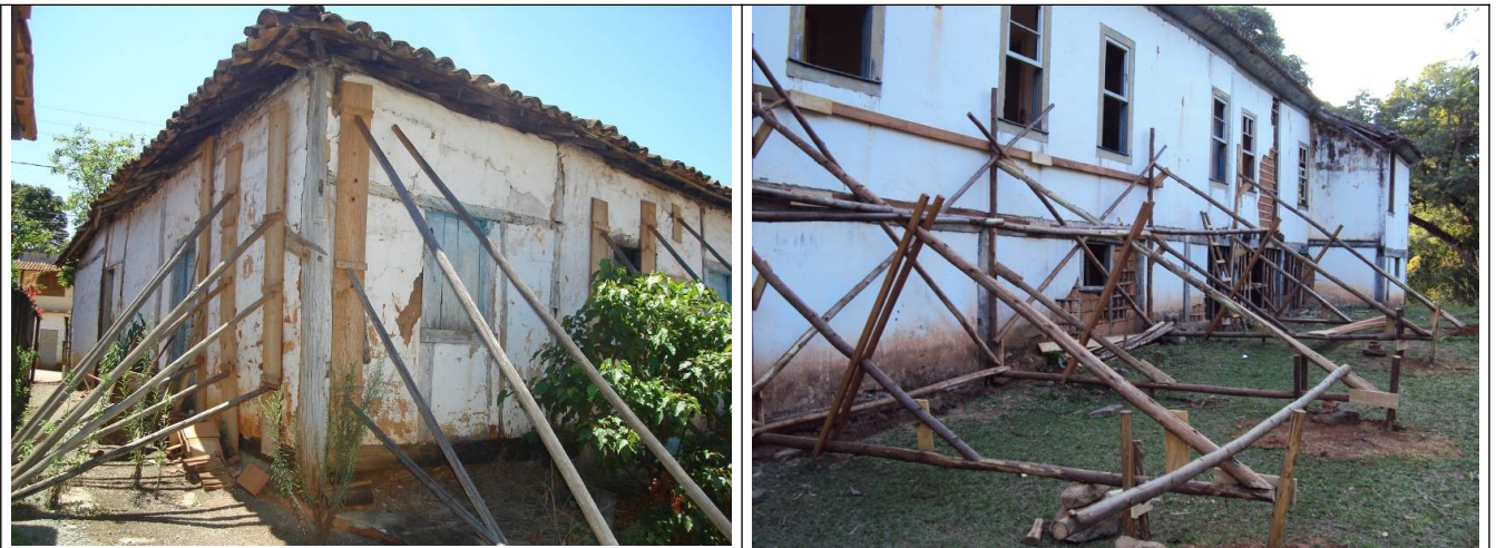
Figuras 04 e 05 – Imagens de escoramentos de fachadas. Fonte : acervo pessoal e do Escritório Técnico do Iphan em São João Del Rei
