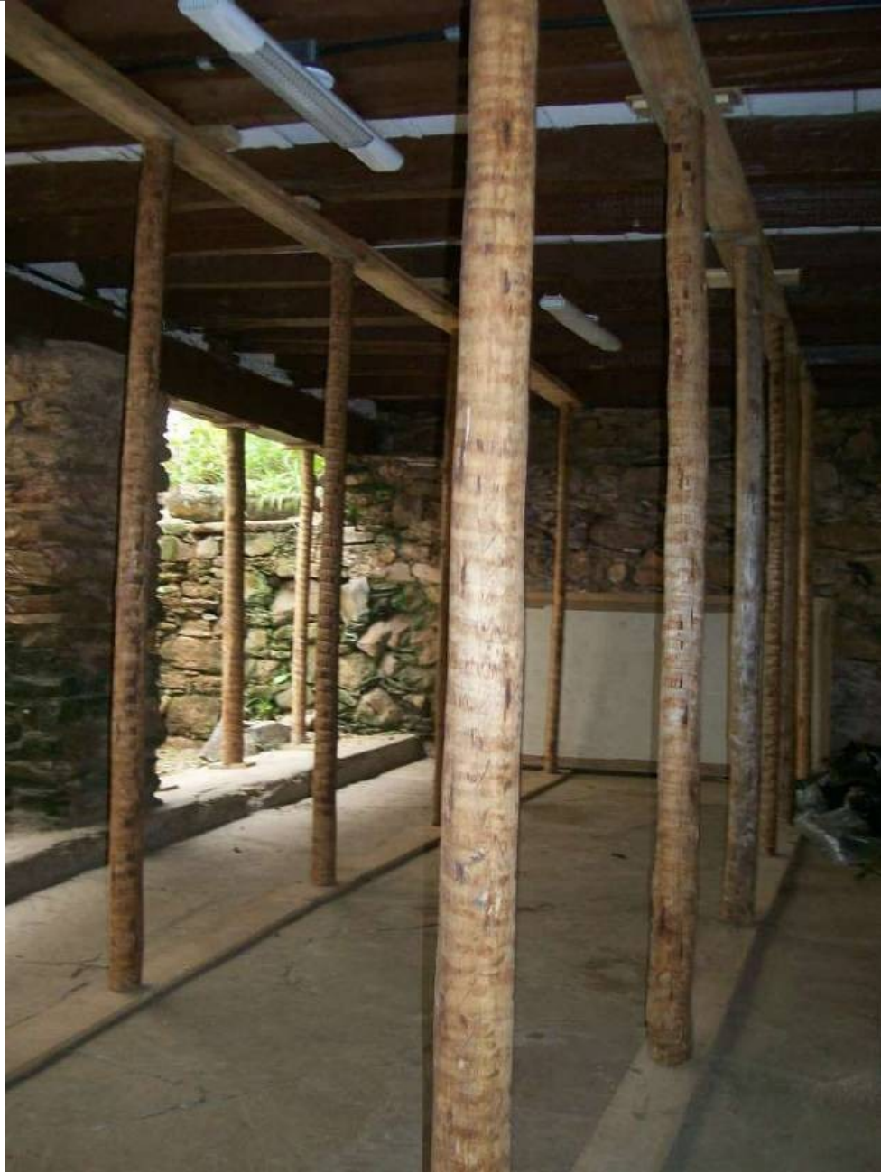
Figura 07 – Esquema para escoramento das peças de madeira do telhado.
