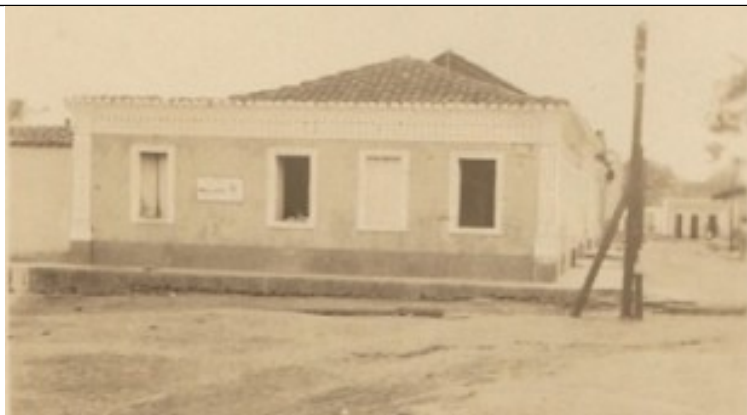
Figura 01 – Imagem antiga da edificação.
