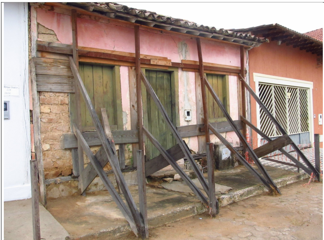
Figura 06 – Imagem de escoramento de fachadas. Fonte: Setor Técnico Promotoria
