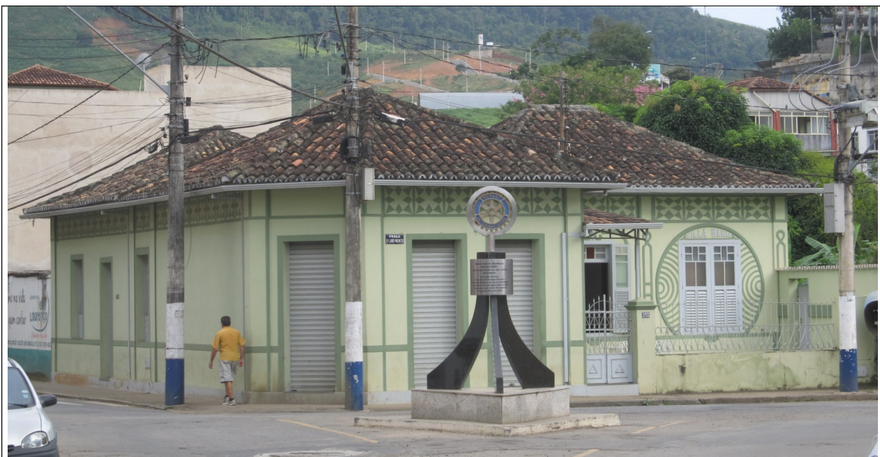
Figura 12- Imóvel inventariado localizado na Praça João Pacheco, 483, com Rua Júlio Bueno, Manhuaçu.
