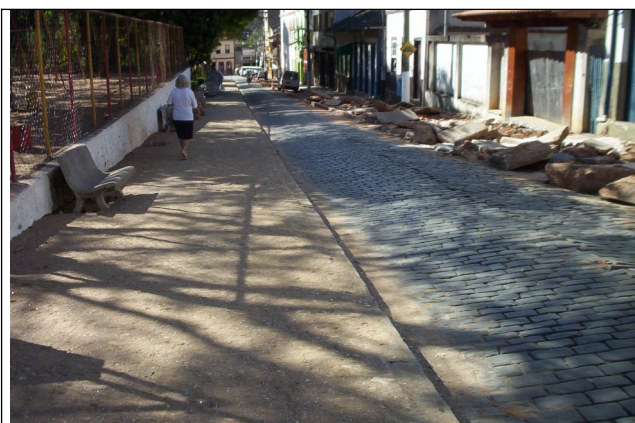
Figura 07 – À direita da imagem, obras da calçada, com retirada das pedras.
