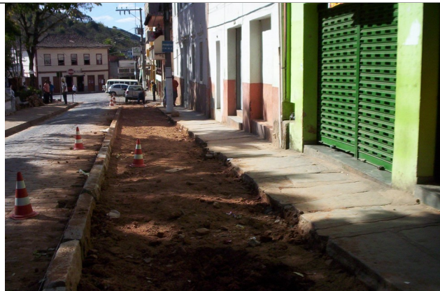
Figura 06 - Calçada com previsão de alargamento e piso de pedras.
