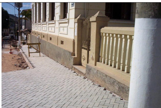
Figura 08 - Piso pré moldado de concreto.
