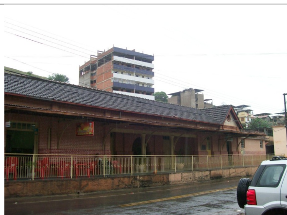
Figura 06 – Edificação na vizinhança que também causa impacto ao bem tombado.
