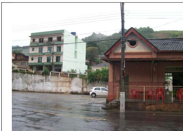
Figura 05 – Edificação em questão vista a partir da Estação Ferroviária
