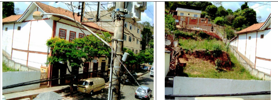
Figuras 14 e 15 – a lateral do imóvel localizado a Estevão Pinto, 18 a 28. De acordo com as informações no expediente, o terreno ao lado vazio tinha um casarão histórico o qual foi vendido e demolido.
