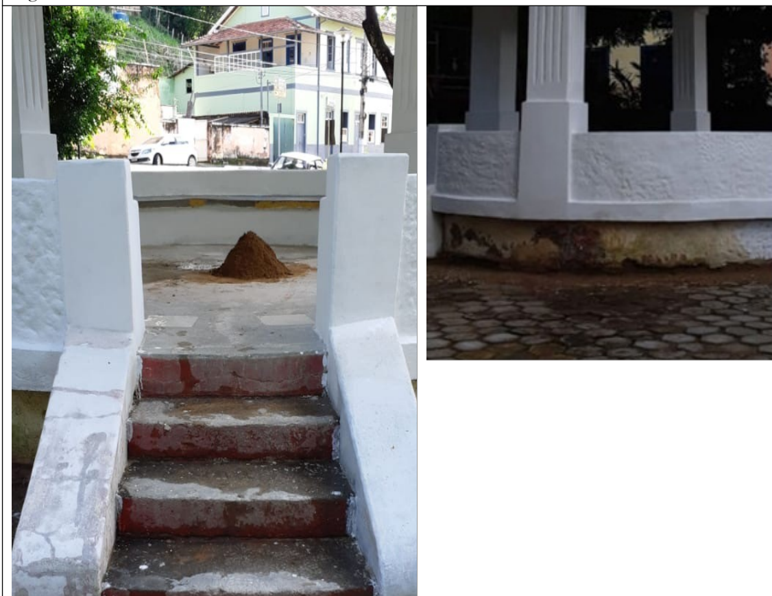
Figura 23 – Escada de acesso em recuperação.
