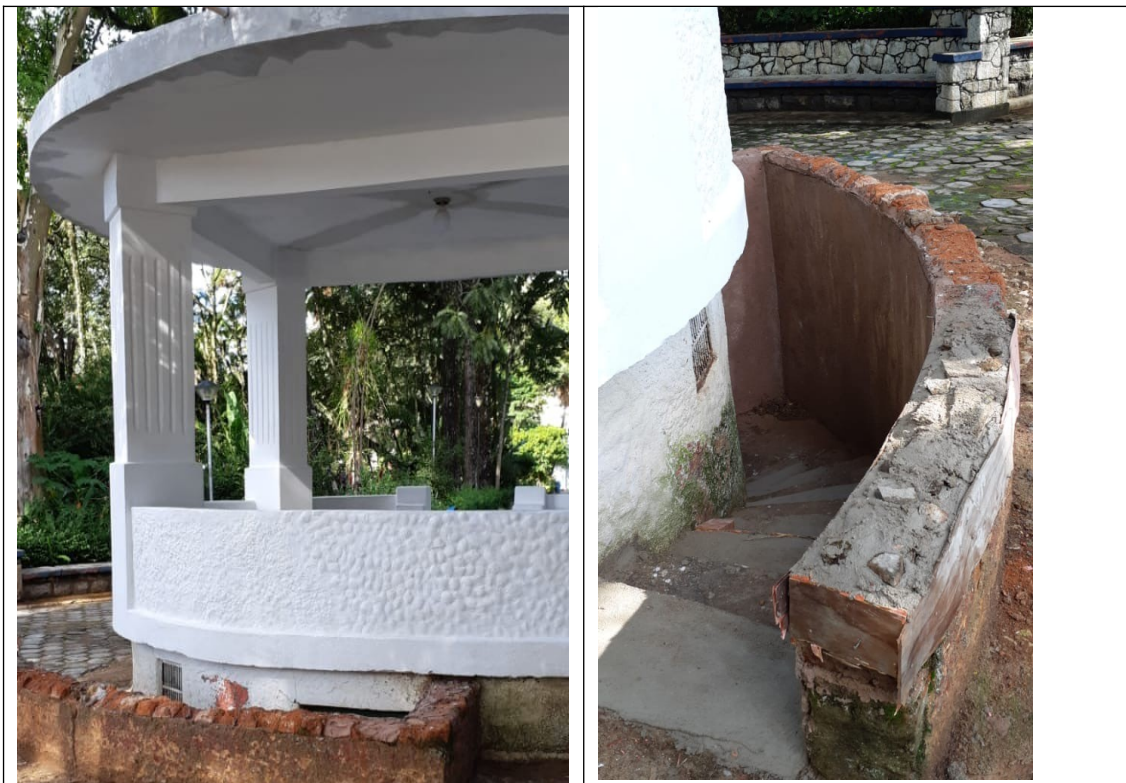
Figuras 21 e 22 – Mureta e escada de acesso ao subsolo ainda inacabados.
