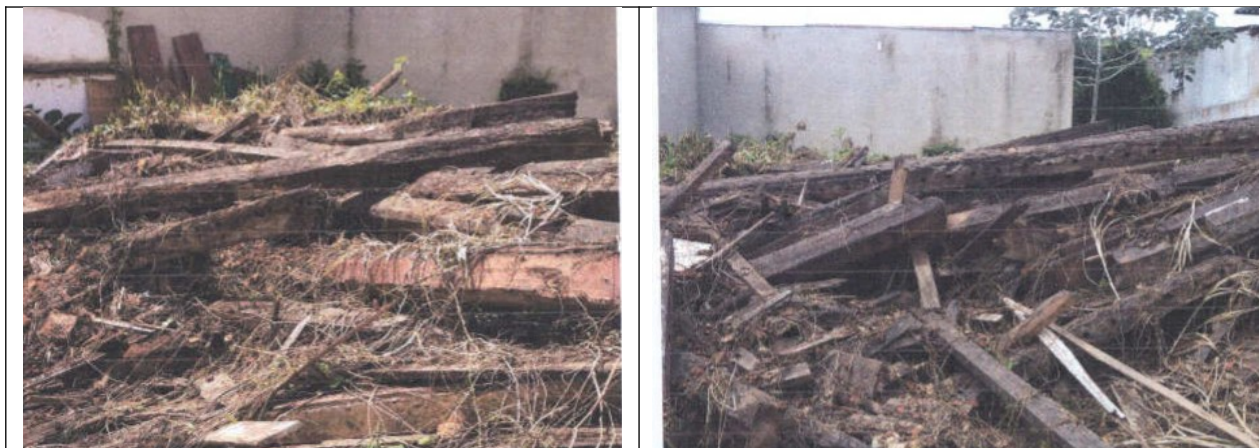
Figuras 05 e 06 – Madeiramento resultante da demolição da “Casa Nemer”. O material pode ser vistoriado após a limpeza do lote.
