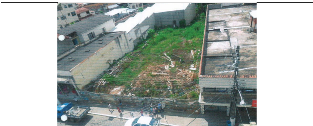
Figura 03 - Aspecto do lote após a demolição da “Casa Nemer”. Fonte: Promotoria de Justiça de Mar de Espanha.
