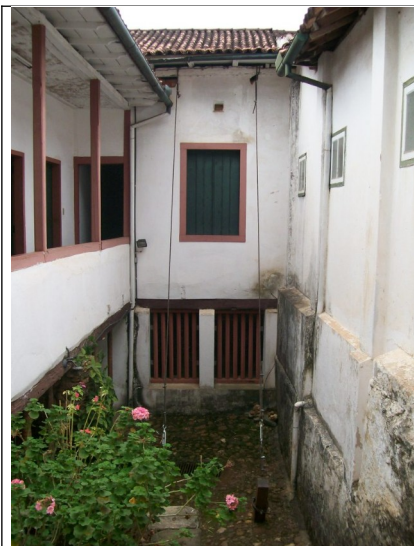
Figura 09 – Escoramento com cabos de aço.
