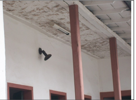
Figuras 12 e 13 – Manchas de umidade nos forros e luminárias inadequadas.
