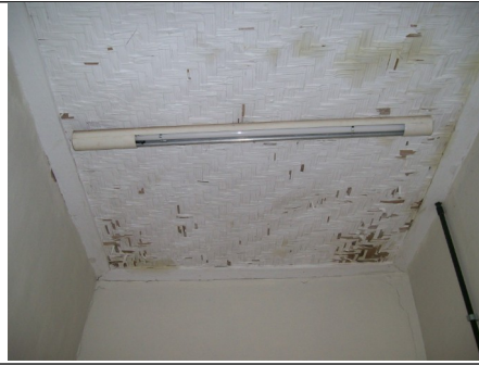
Figuras 12 e 13 – Manchas de umidade nos forros e luminárias inadequadas.
