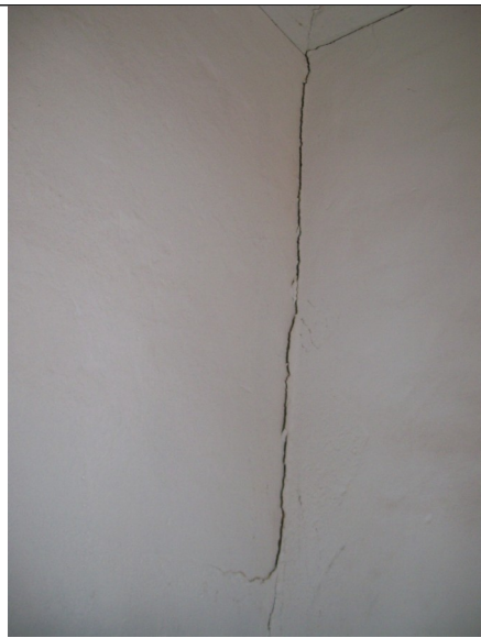
Figuras 15 e 16 – Trincas generalizadas nas alvenarias.
