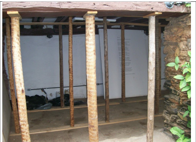
Figura 10 – Escoramento do piso e barrotes.
