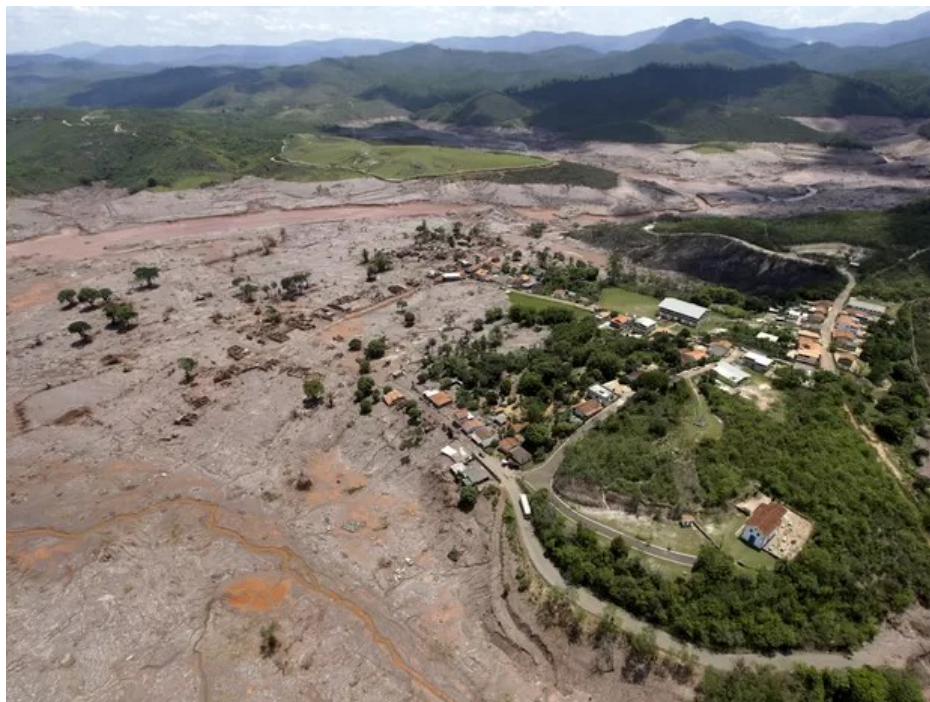
Figura 04 – Aspecto do subdistrito de Bento Rodrigues após o rompimento da barragem de Fundão. Vista a partir da Igreja das Mercês. Igreja de São Bento está sinalizada.
