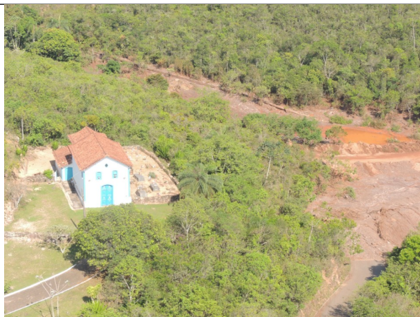
Figura 06 – Vista aérea da Capela Nossa Senhora das Mercês, onde se observa a lama de rejeitos no entorno.
